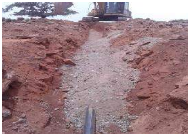
Figure 6: Pose de Conduite d'Ait Ibourk
