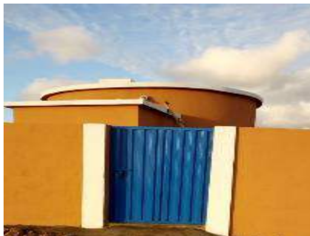
Figure 5: Réservoir semi enterré 100 m3 d'Ait Ibourk
