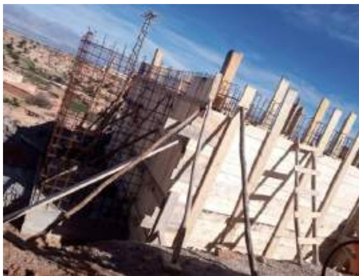
Figure 6 Construction du réservoir de 50 m 3 d'Arazane
