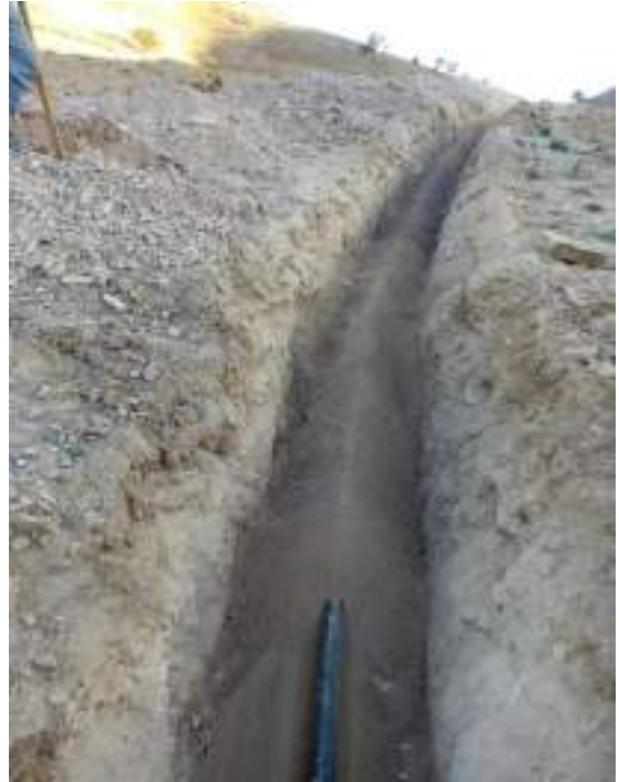
Figure 7 Travaux de pose de conduite de la partie Arazane
