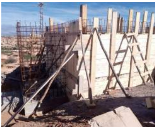
Figure 6 Construction du réservoir de 50 m 3 d'Arazane
