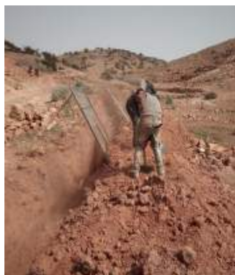
Figure 22 : Pose de la première partie de conduite de distribution de la partie Toughmart
