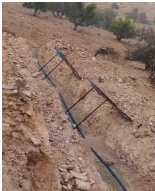
Figure 25 : Tranchées de pose de la conduite principale
