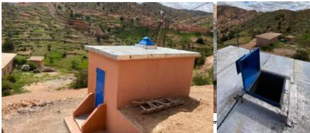
Figure 19 : Finalisation du génie civil et équipements de la bâche d'Agni N'Ouamane
