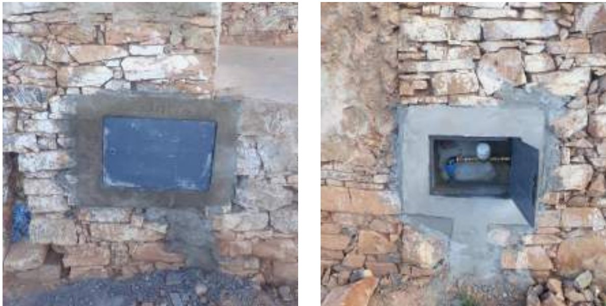
Figure 27 : Branchements individuels de la dernière tranche du projet Arazane
