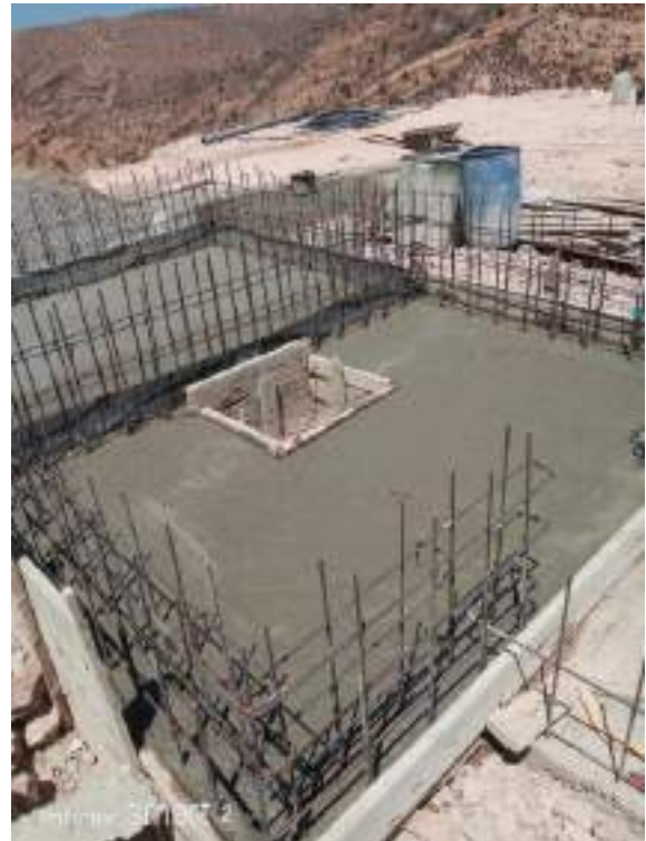
Figure 20 Radier du réservoir d'Ait Ighir
