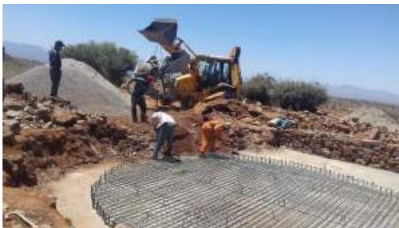
Figure 12: Travaux de construction du réservoir semi enterré 100 m 3 d'Ait Ibourk
