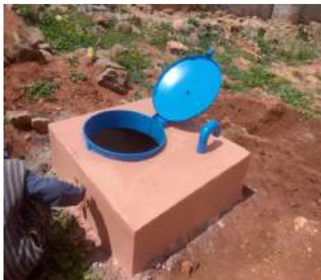
Figure 26 : Génie civil et équipement des regards
