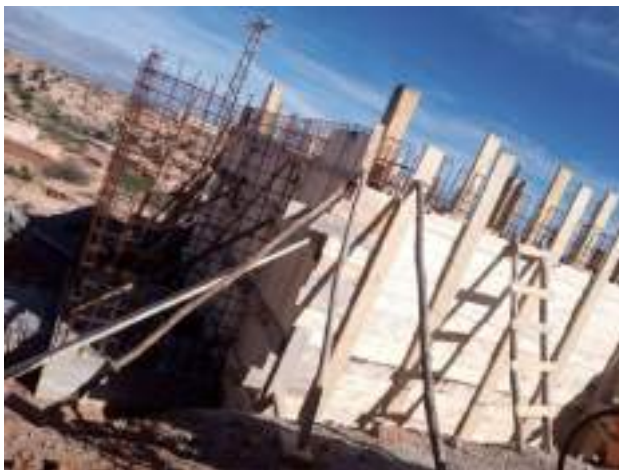
Figure 14 : Génie civil du réservoir de 50 m 3
