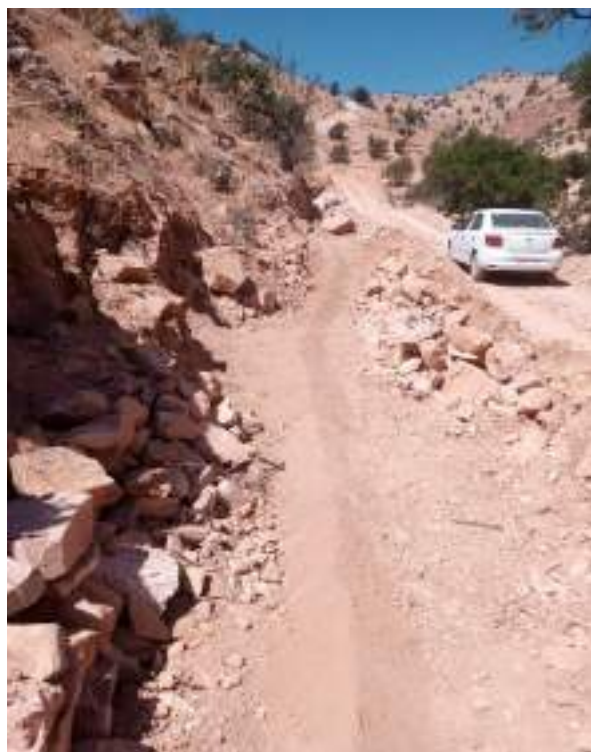
Figure 25 : Tranchées de pose de la conduite principale
