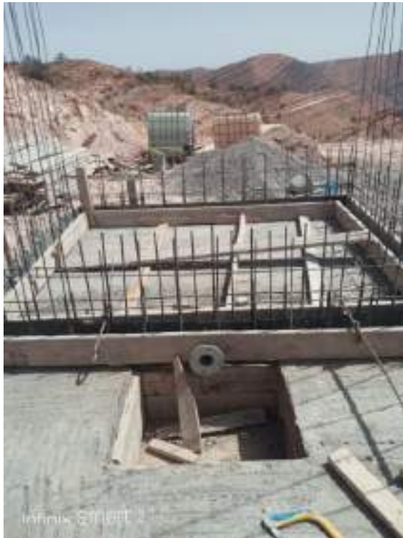
Figure 20 Radier du réservoir d'Ait Ighir
