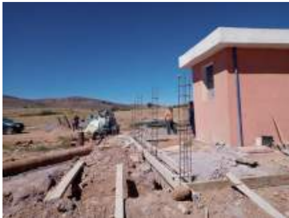
Figure 7 : Construction du mur de clôture du local de pompage Ait Hsayn
