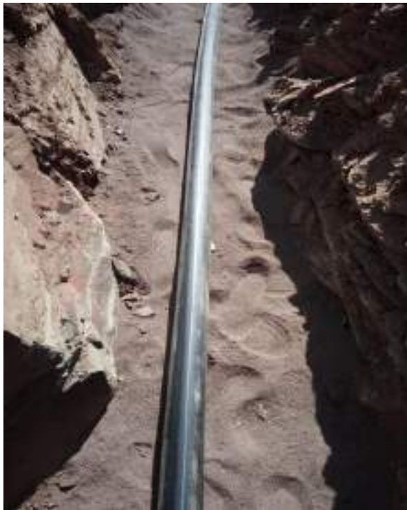
Figure 8 : Installation de la conduite de refoulement vers le réservoir de 100m3
