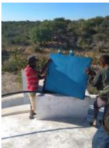
Figure 11 : Tuyau d'amenée du forage de Soalary vers le réservoir d'Anakao
