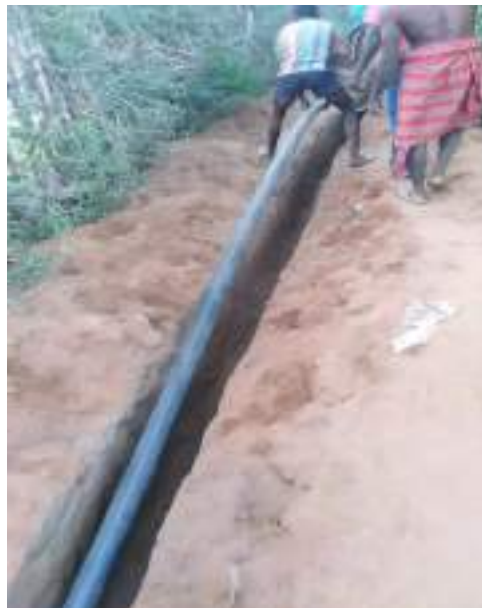
Figure 14: Installation des conduites d'extension
