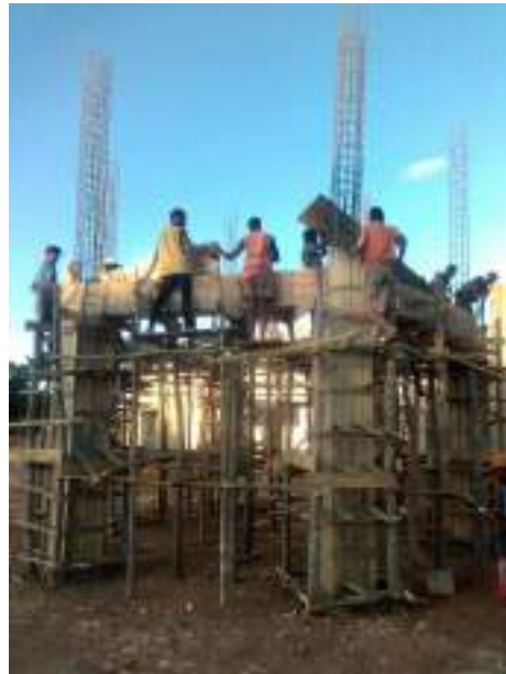
Figure 13: Travaux de construction du réservoir de 70m 3 , juin 2022
