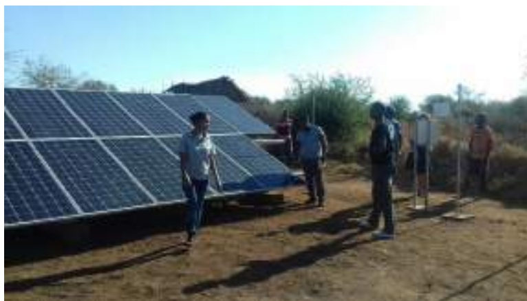
Figure 6 : Inspection du champ solaire d'Ankazoabo (la gérante, à droite de la photo)
