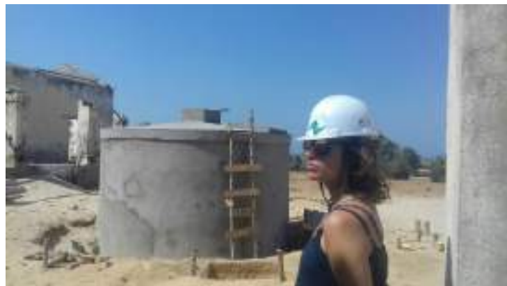
Figure 15 : Inspection du réservoir de Tsihake, Fitsitike
