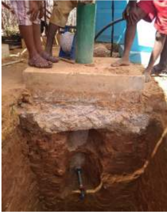
Figure 8 - Fouilles autour du forage pour positionner le premier collier de prise sur le tubage
