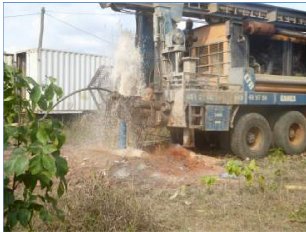
Opérations de foration et de développement du forage de Nkong-Ondoa (il faut dire que ce forage pourrait servir à une mini-adduction d'eau pour le village, car son débit pourrait être \geq 6\text{m}^3/\text{h} ) © AUNTD 2022
