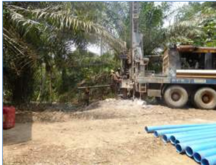
Travaux de foration à Angon (ABOA) © AUNTD 2022
