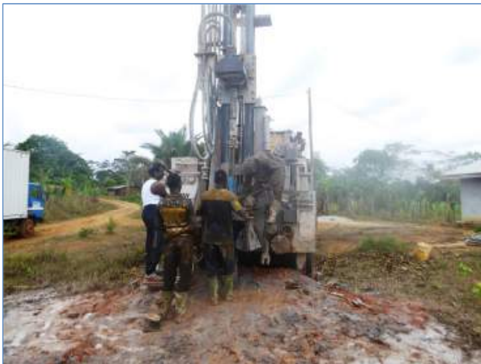
Opérations de foration et de développement du forage de Nkong-Ondoa (il faut dire que ce forage pourrait servir à une mini-adduction d'eau pour le village, car son débit pourrait être \geq 6\text{m}^3/\text{h} ) © AUNTD 2022
