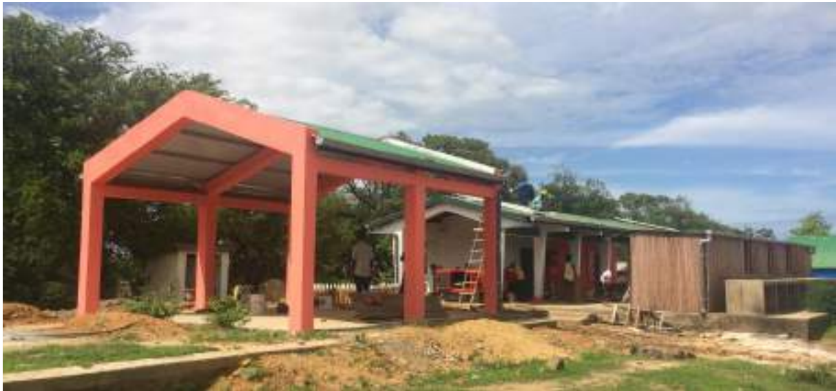
Figure 8 : Photo des infrastructures le jour de la réception provisoire / 15.12.2020
