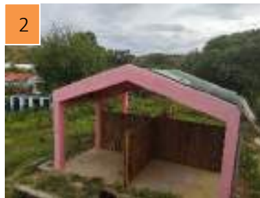
Figure 8 : hangar des activités productives
