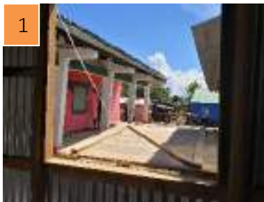
Figure 7 : bâtiment couvert rénové
