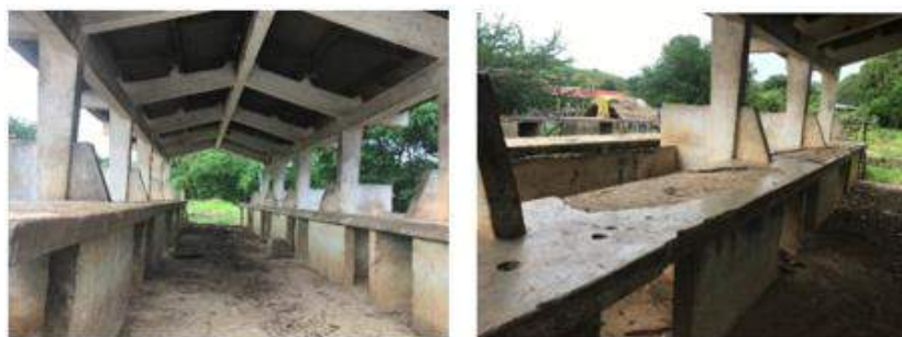
Figure 12 : Bâtiment de marché communal, objet de rénovation dans le cadre du projet
