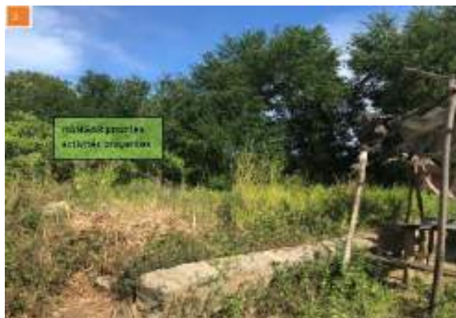
Figure 16 : Photo prise au démarrage du chantier / emplacement de l'actuel hangar
