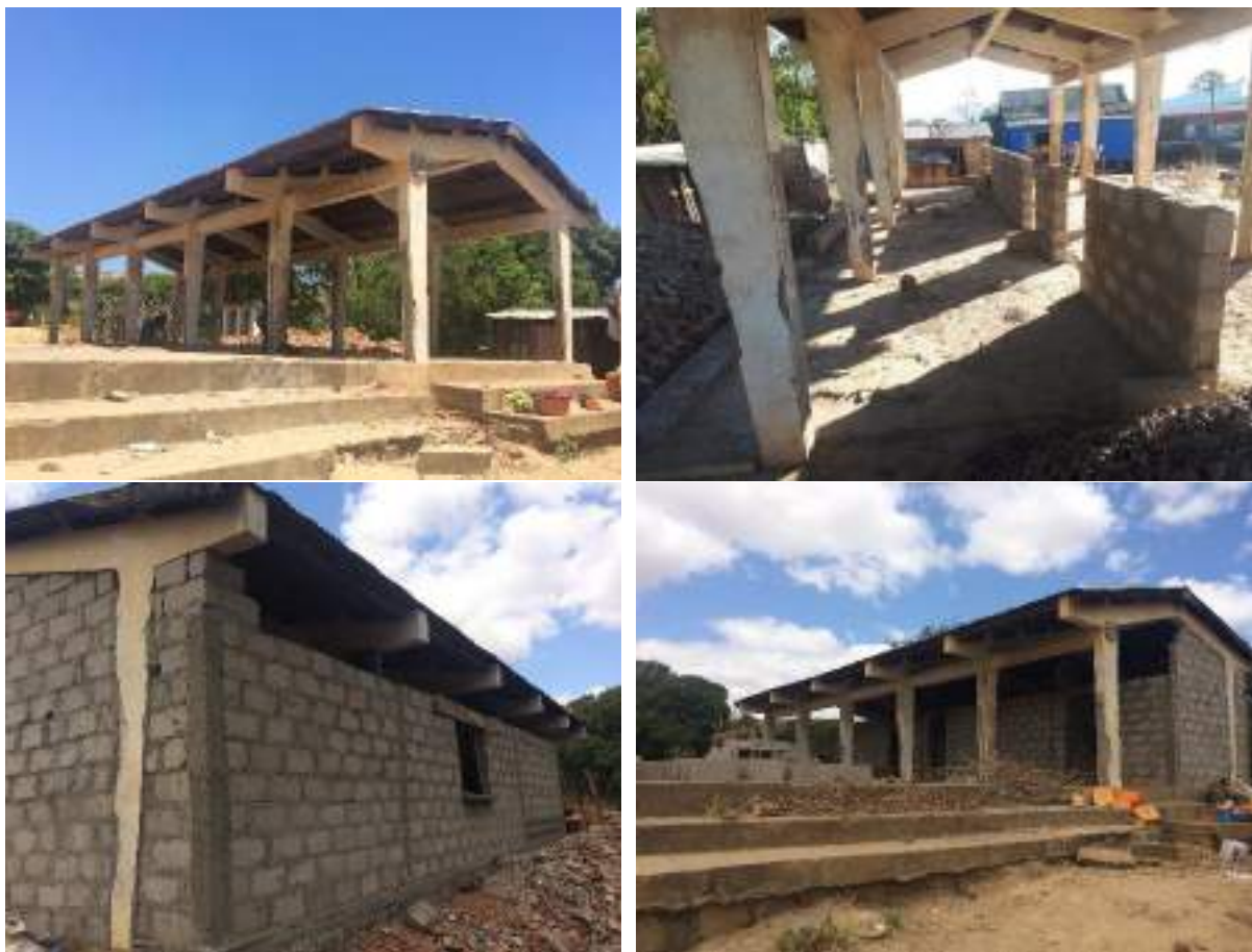
Figure 15 : Photos de la réalisations / rénovation du bâtiment et construction des locaux
