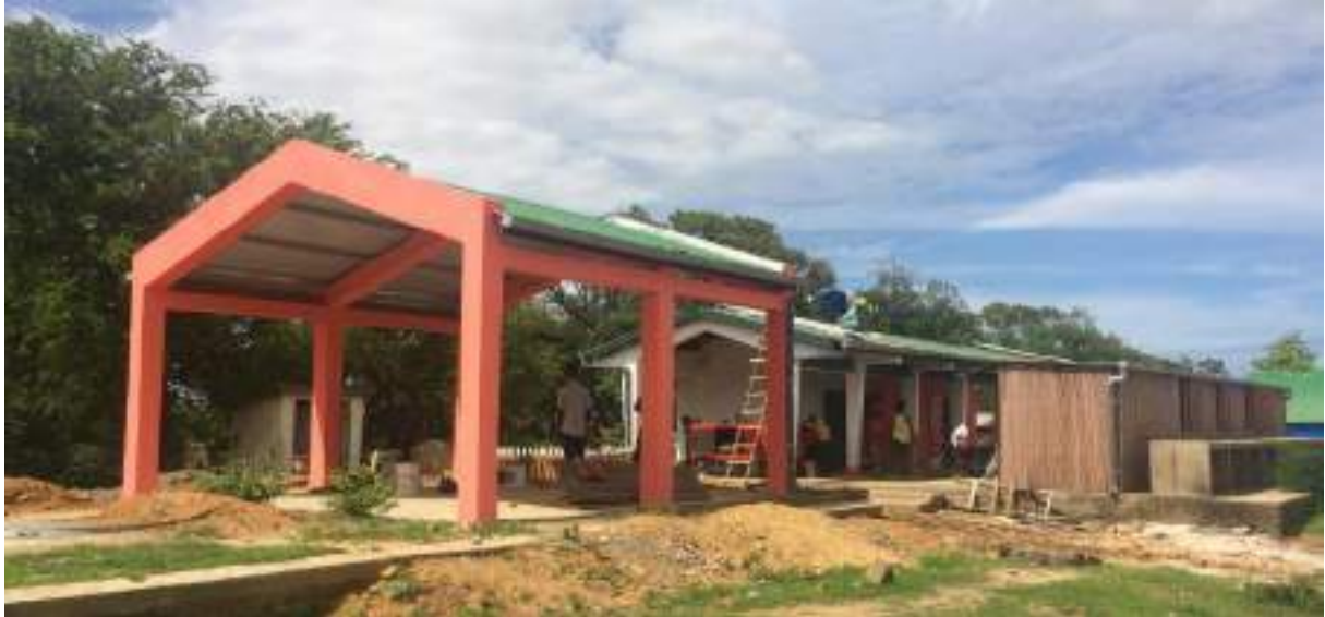
Figure 20 : Photo des infrastructures le jour de la réception provisoire le 15.12.2020
