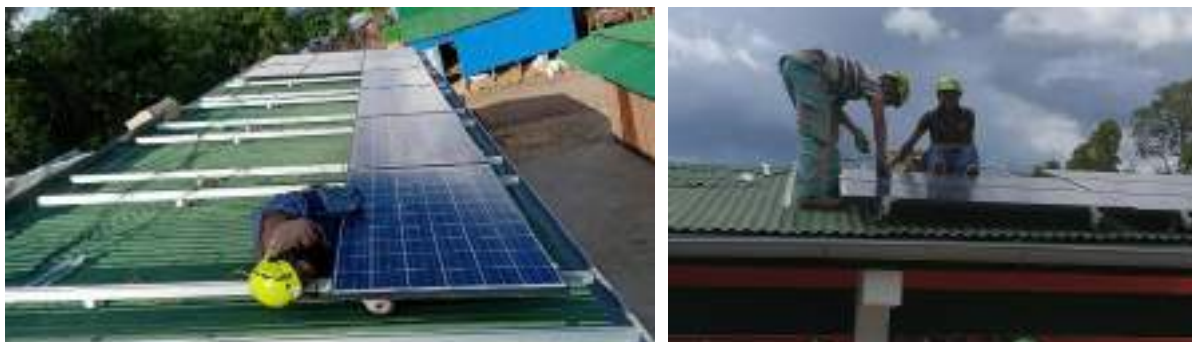
Figure 25 : Pose des panneaux solaires par les équipes d'ANKA MADAGASCAR – décembre 2020
