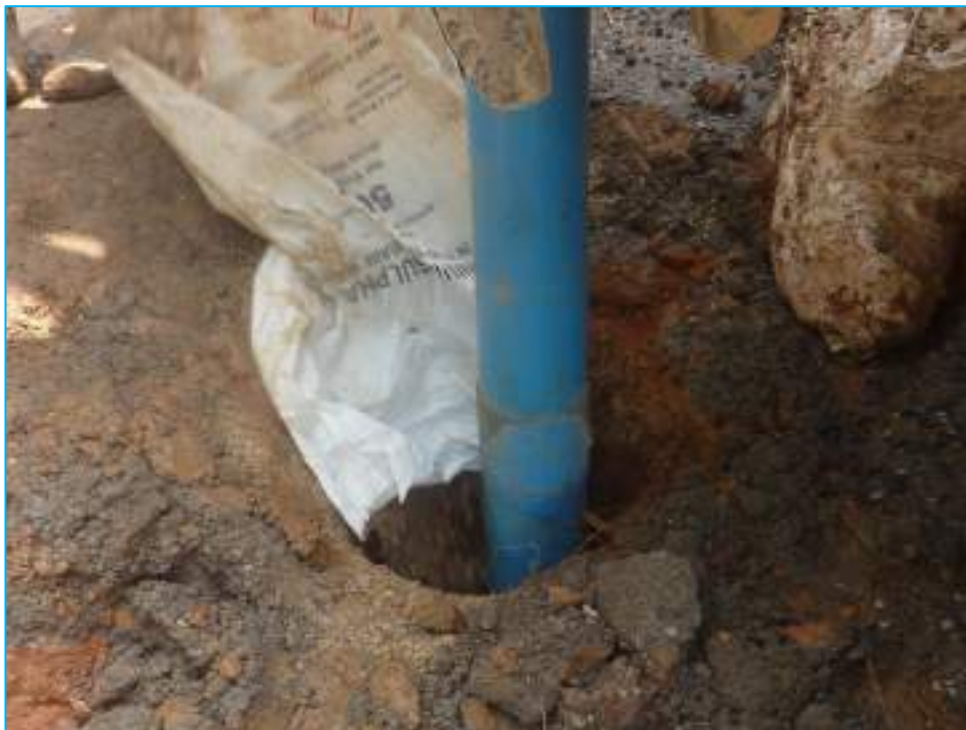
ENFOUISSEMENT DU MASSIF FILTRANT DANS L'ESPACE ANNULAIRE
