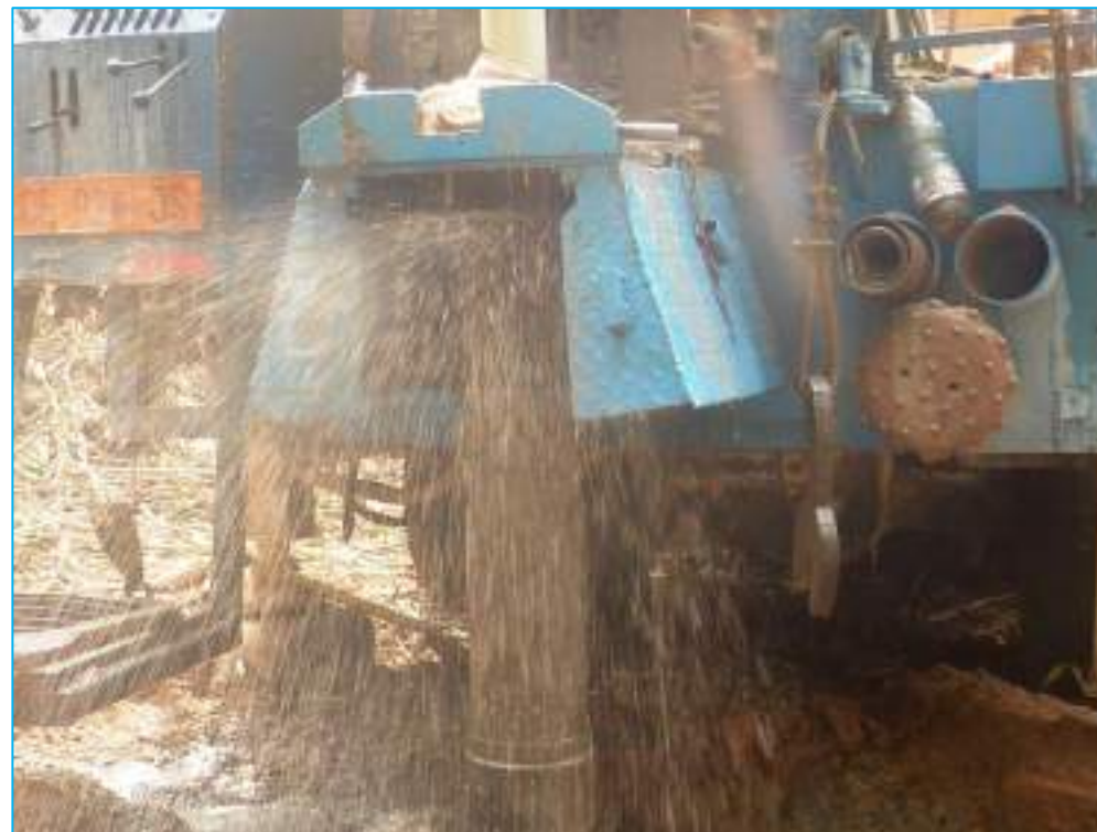
ATELIER DE FORAGE DURANT LES TRAVAUX L'ON A CONSTATÉ DE FORTES VENUES D'EAU SANS ARRÊT DÈS LA PERCÉ DE LA PREMIÈRE FRACTURE
