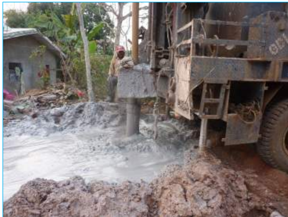
Ici forte présence de l'argileuse à l'origine de la couleur blanche persistante de l'eau
