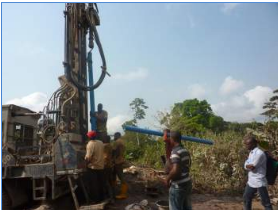
Opérations d'équipement du forage
