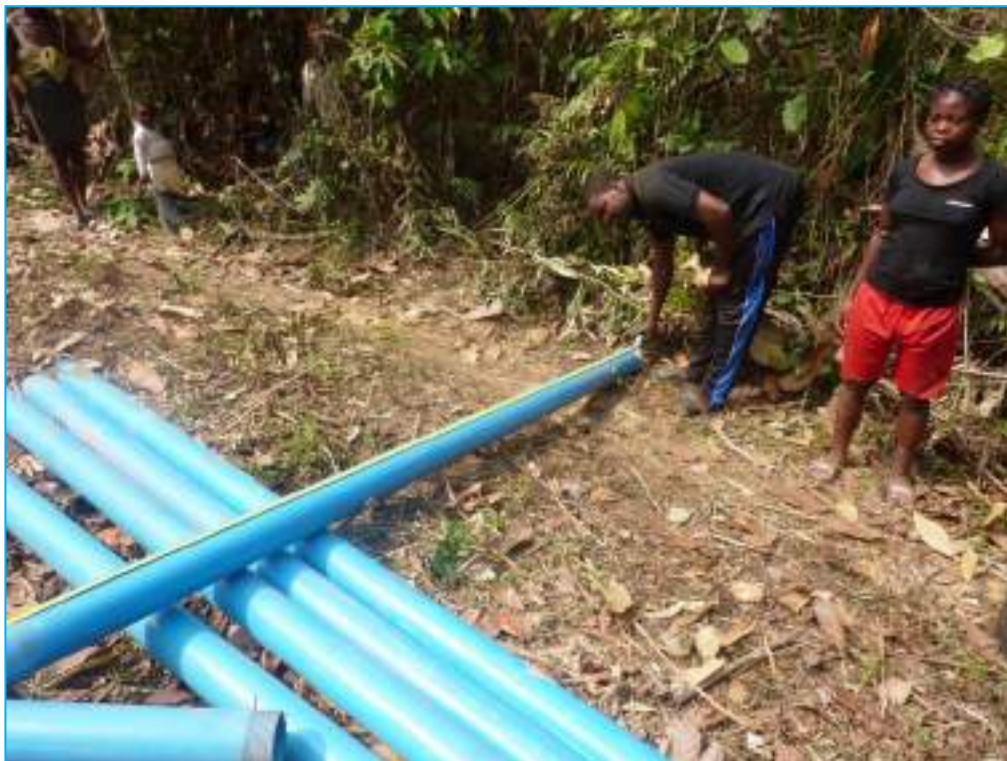
PRÉPARATION DE L'ÉQUIPEMENT DU FORAGE AVEC LES PVC
