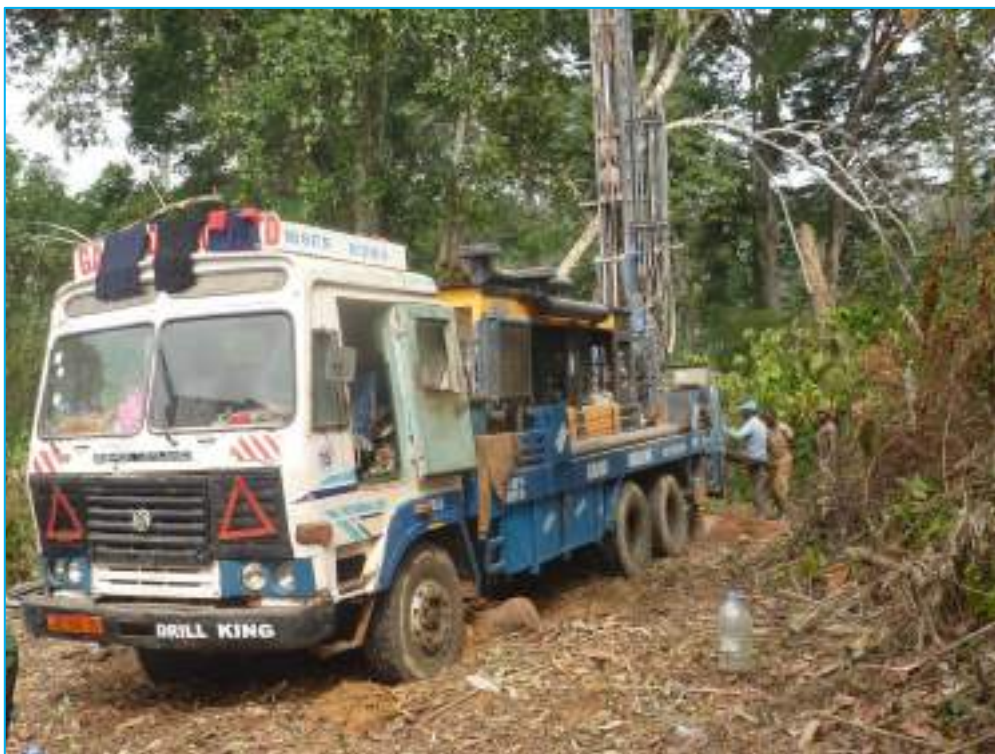
ATELIER DE FORAGE DURANT LES TRAVAUX L'ON A CONSTATÉ DE FORTES VENUES D'EAU SANS ARRÊT DÈS LA PERCÉ DE LA PREMIÈRE FRACTURE
