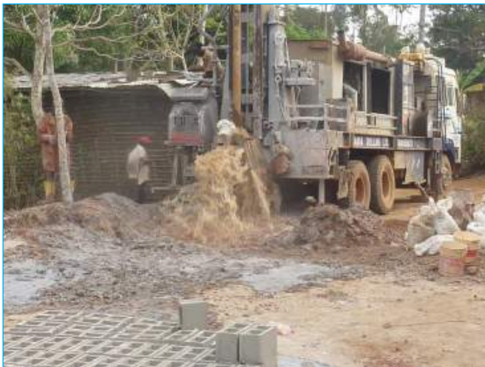
Observation des premières venues d'eau à 28 mètres dans les altérations
