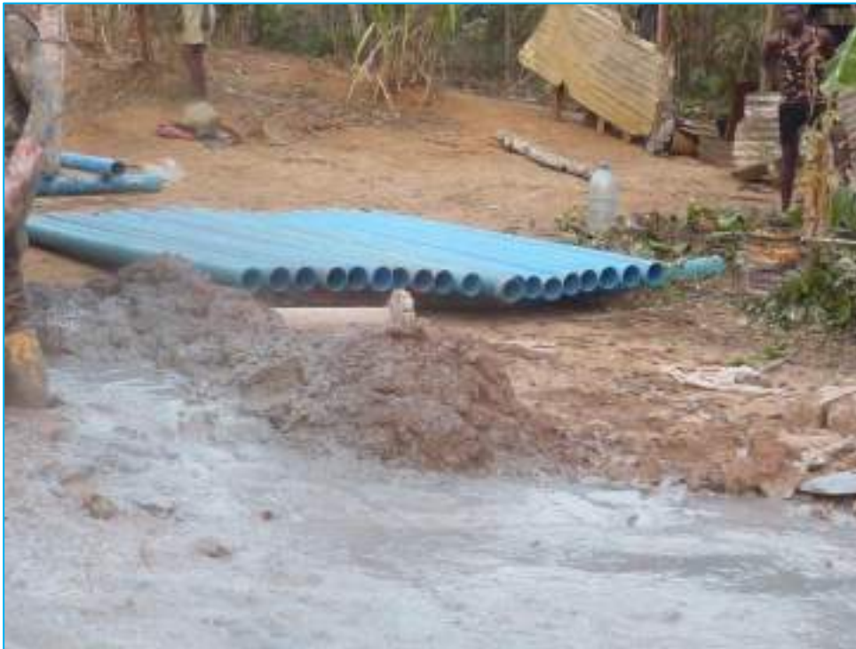
Tuyaux PVC de 3m utilisés pour l'équipement du forage (ici, 20 tuyaux PVC dont 16 PVC pleins et 04 PVC crépinés)
