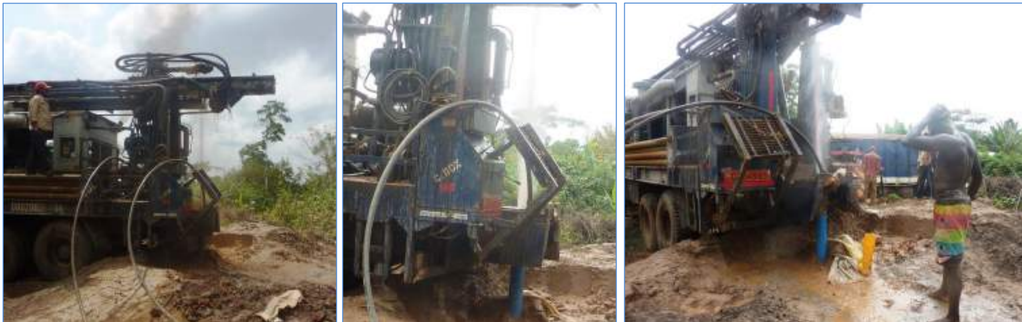
Opérations de nettoyage du forage
