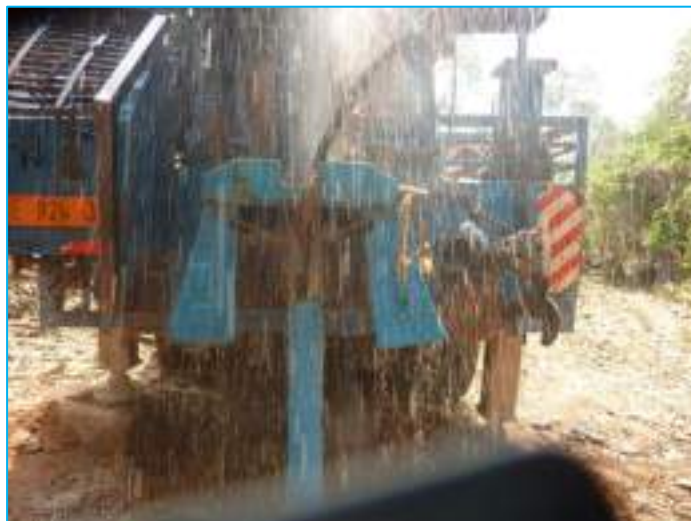
DÉVELOPPEMENT DU FORAGE À L'AIR-LIFT JUSQU'À OBTENTION D'UNE EAU CLAIRE
