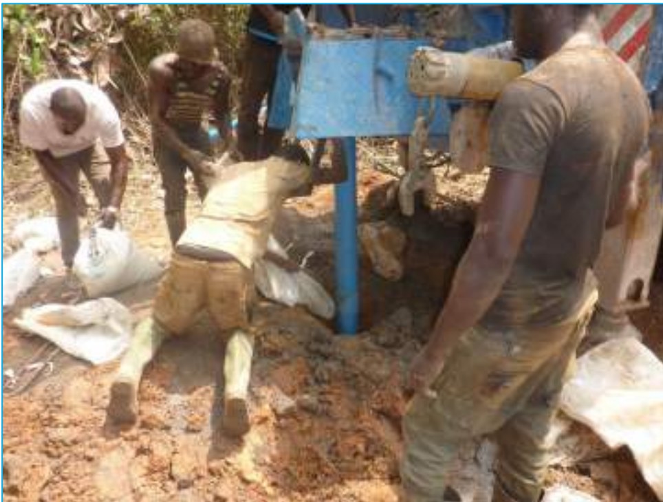
ENFOUISSEMENT DU MASSIF FILTRANT DANS L'ESPACE ANNULAIRE
