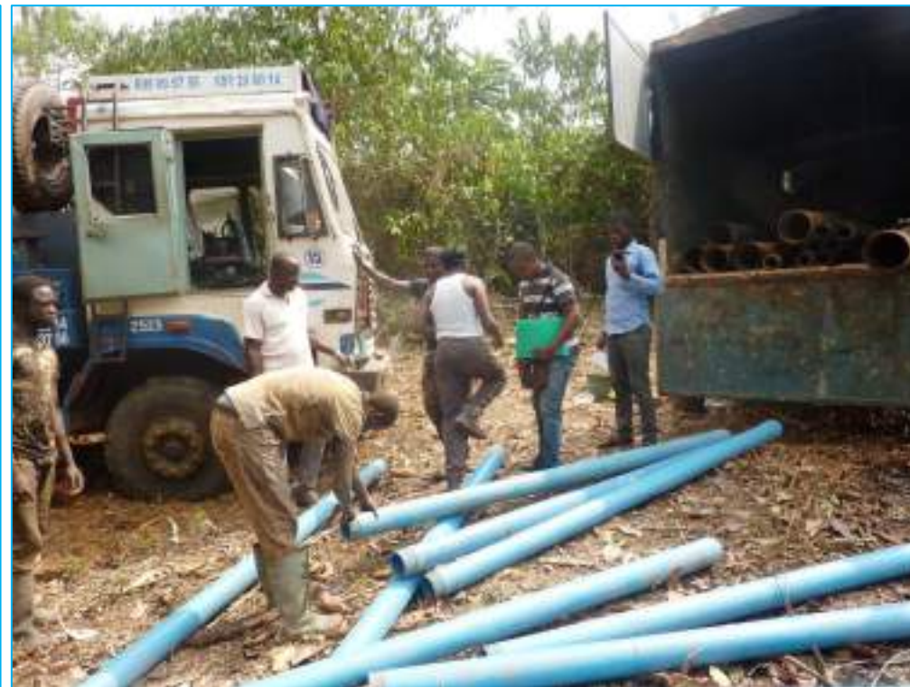
PRÉPARATION DE L'ÉQUIPEMENT DU FORAGE AVEC LES PVC
