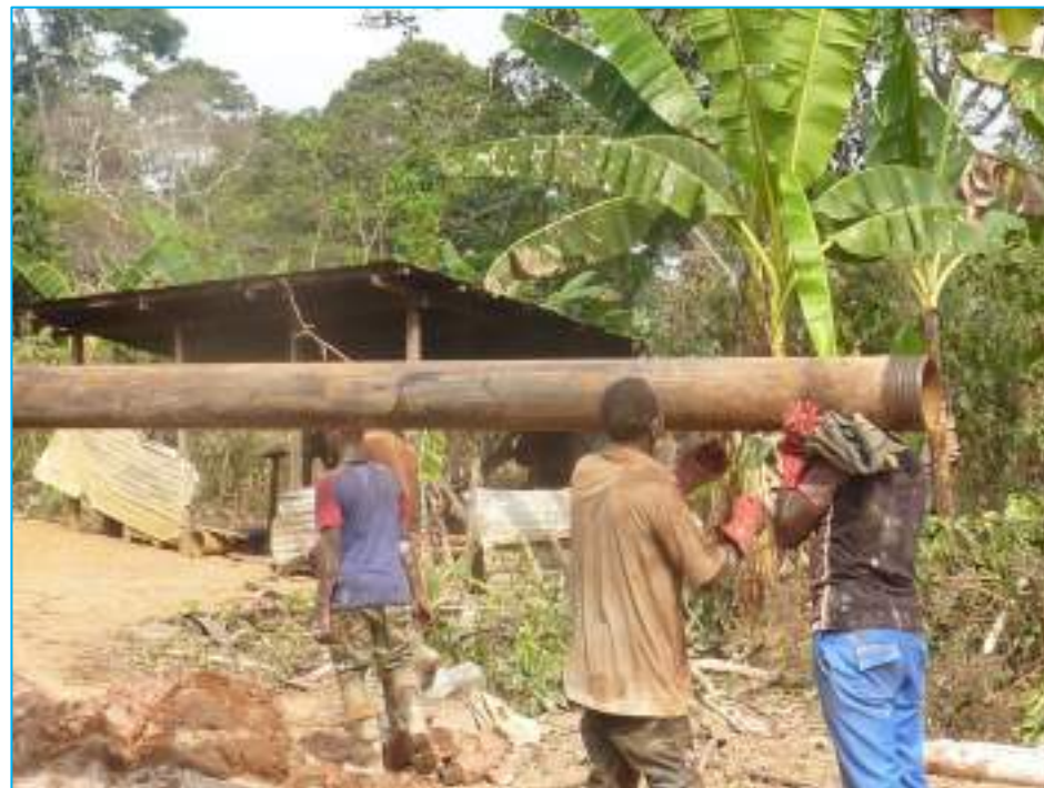
Kesine en acier utilisée lors de la foration dans les altérations
