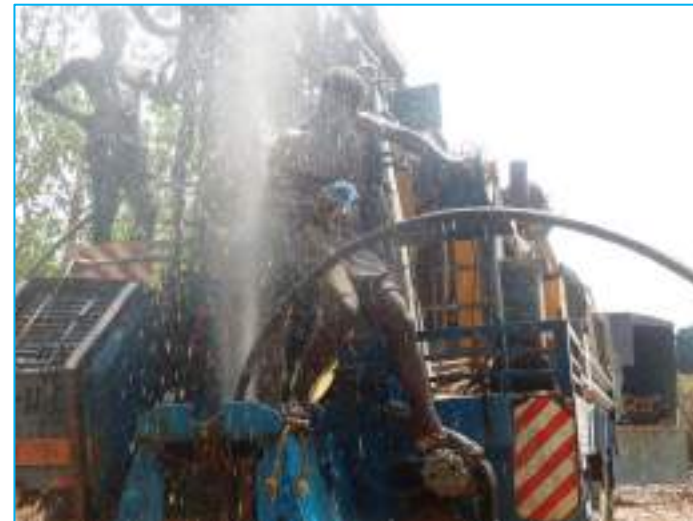
DÉVELOPPEMENT DU FORAGE À L'AIR-LIFT JUSQU'À OBTENTION D'UNE EAU CLAIRE
