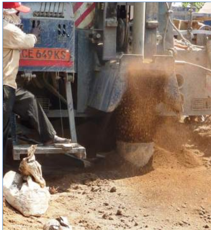
Travaux de foration (ici durant la traversée des altérites)
