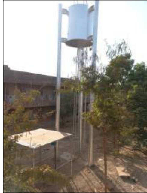
Le Château d'eau métallique de 10 m 3
