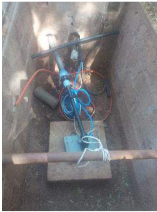
Installation de la pompe de refoulement et de ses accessoires
