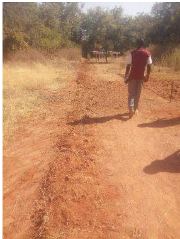
Pose des conduites
