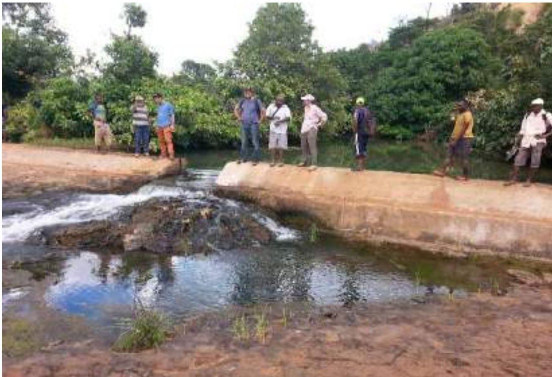
Photo du barrage existant
