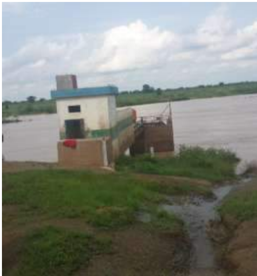
Tour de captage
