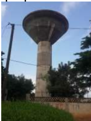
Vue du château d'eau
