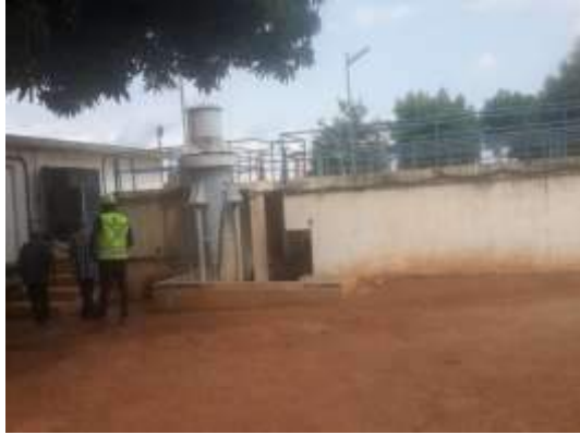
Vue de la station de traitement
