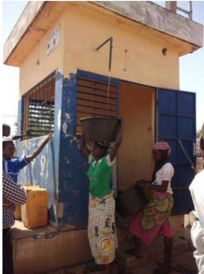
Kiosque à eau, Mango
