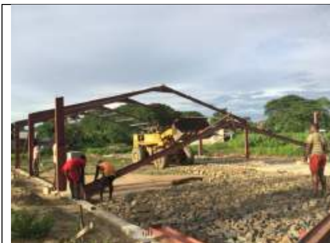
Figure 37 : Montage de la charpente
