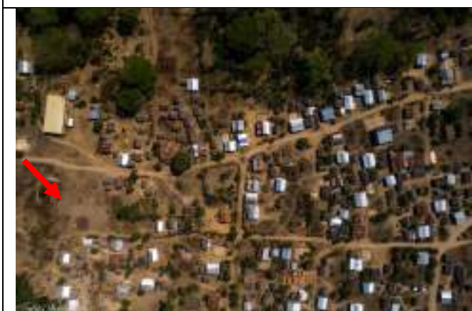
Figure 39 : Vue du dessus du village avant début des travaux, centrale en construction à l'emplacement de la flèche
