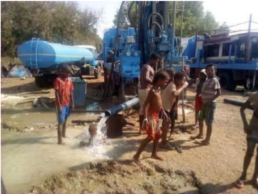
Photo 1– Travaux de forage
