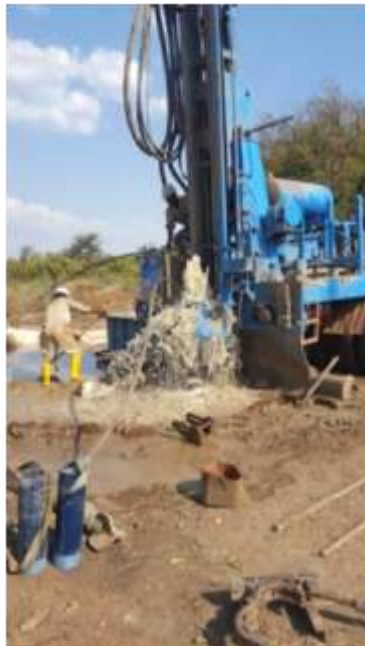
Opération de forage à Ankazoabo
