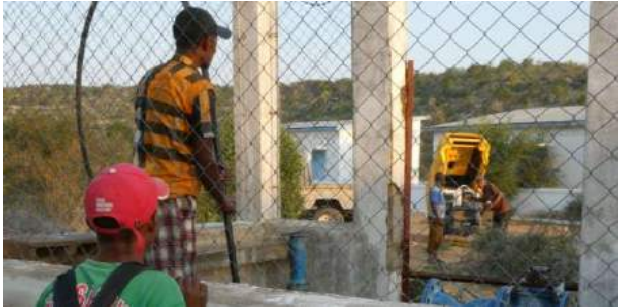
Figure 9 - Soufflage du forage d'Anakao, Août 2018
