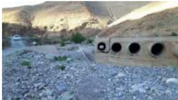
Figure 34 : Photographies des ouvrages de franchissements détruits sur la route en direction de Maguenoun
