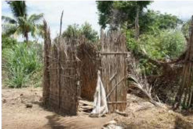
Figure 16 : Latrine en avec mur en vondro, sans toit, et dalle en bois
