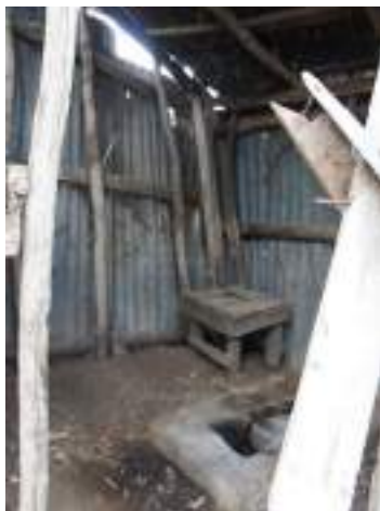
Figure 20 : Intérieur d'une latrine avec une dalle cimentée, mur et toit en tôle
