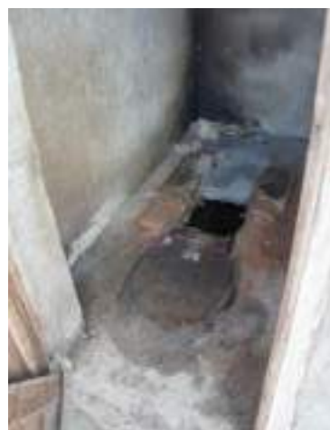
Figure 19 : Intérieur d'une latrine avec dalle cimenté lissée
