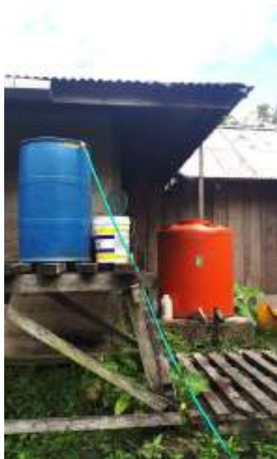
9. récupération d'eau de pluie
