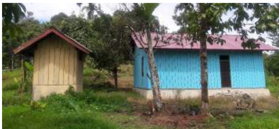
Maison récente et latrine indépendante
