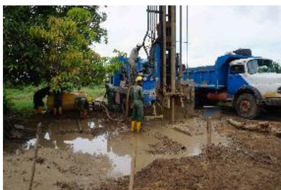
Forage à boue, Ambahikily - Entreprise CRS
