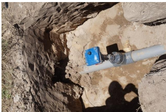
Positionnement d'une ventouse sur la conduite principale en amont du village
