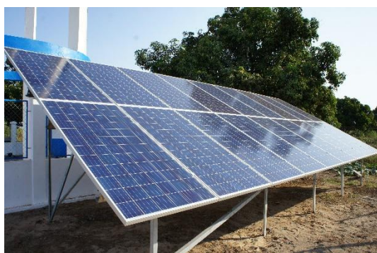
Installation des 18 panneaux solaires de 300 Watt chacun
