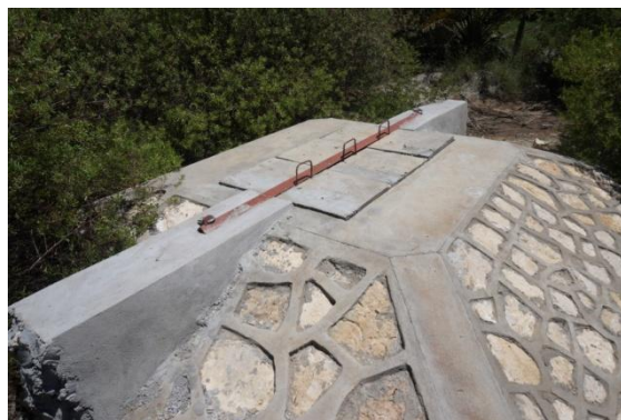
Ouvrage de protection du forage
