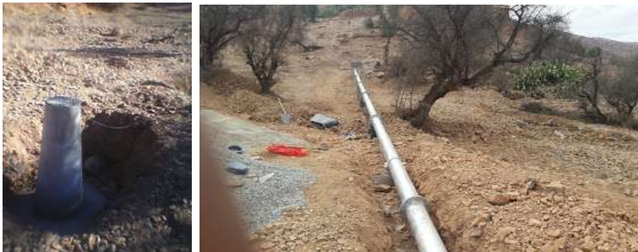
Photos de la traversée de l'Oued du projet d'assainissement de Ben Ali.
