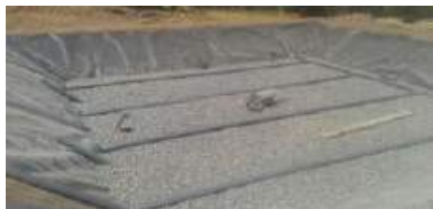
Tuyaux et pose du drainage
