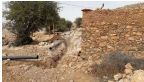
Travaux de terrassement
