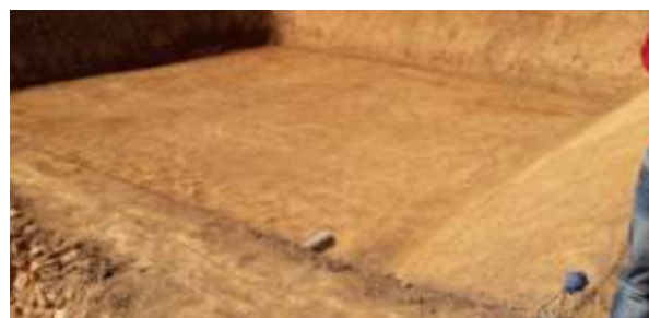
Réglage des pentes et vérification des côtes
