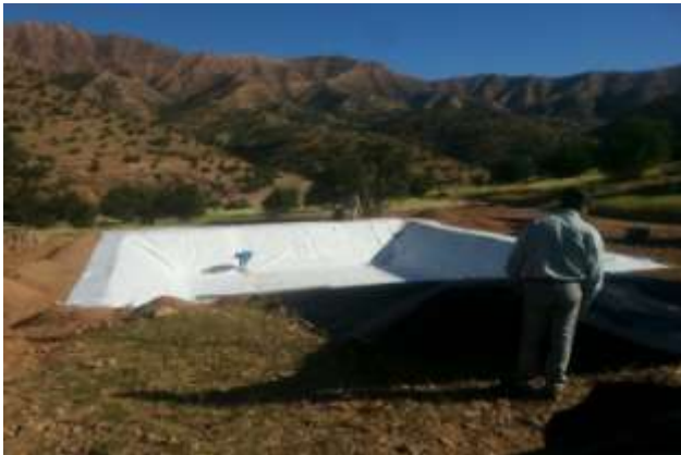
Pose du géotextile puis de la membrane
