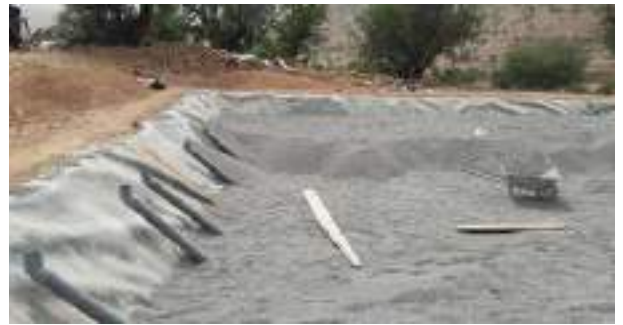
Pose des différentes couches de gravier
