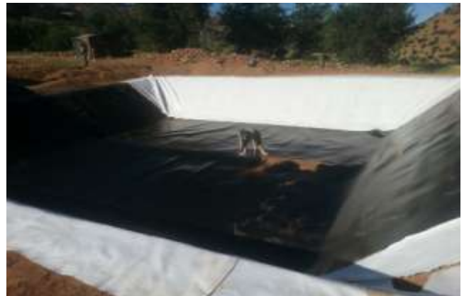
Pose du géotextile puis de la membrane
