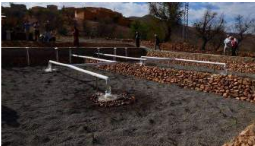
Essai de réception provisoire de la STEP
