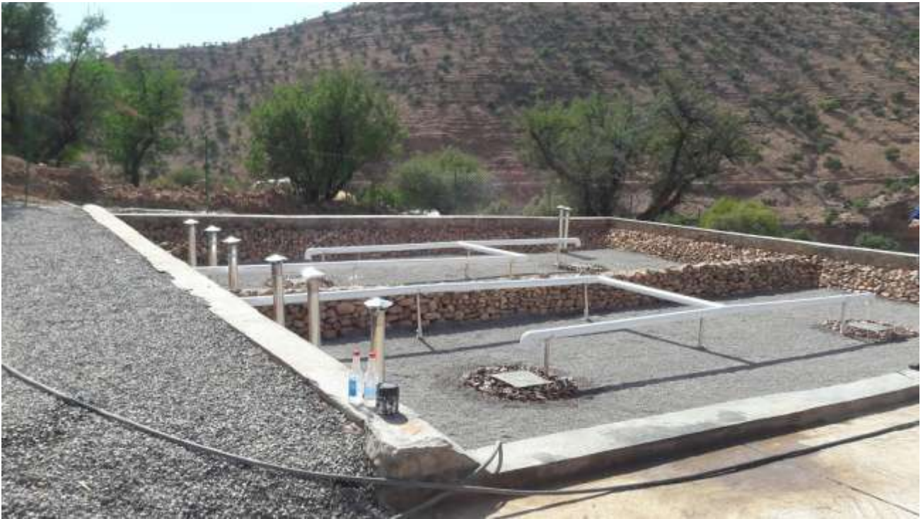
Station d'épuration après achèvement des travaux
