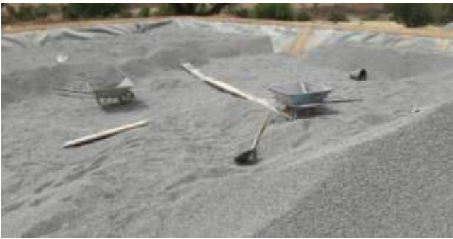
Pose des différentes couches de gravier
