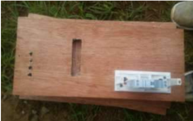
Panneau troué avec support disjoncteur fixé
