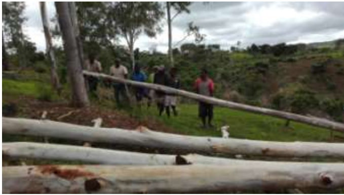
Figure 11 : Amené des poteaux sur la rampe de traitement
