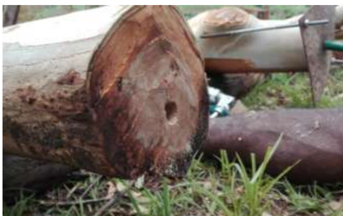
Figure 9 : Perforation des poteaux au niveau du pied pour injection du liquide de traitement
