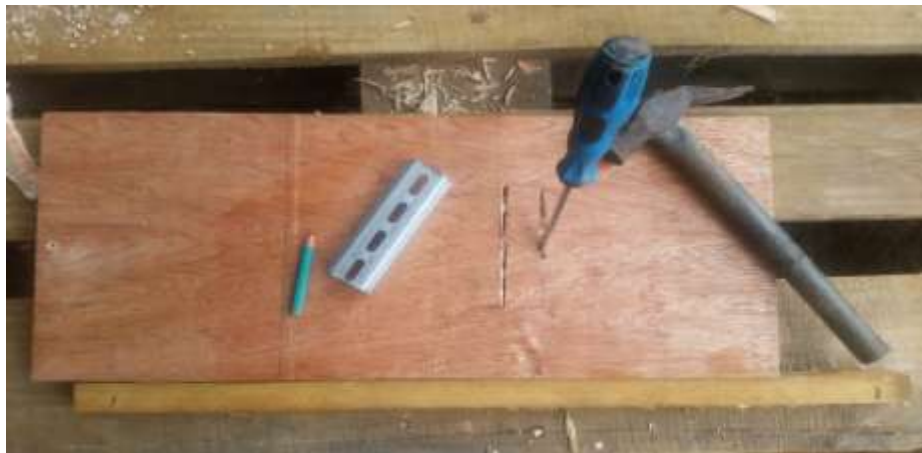
Réalisation d'un trou pour le rail DIN
