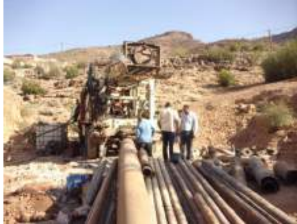
Travaux d'alésage du forage
