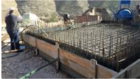
Construction du radier du réservoir
