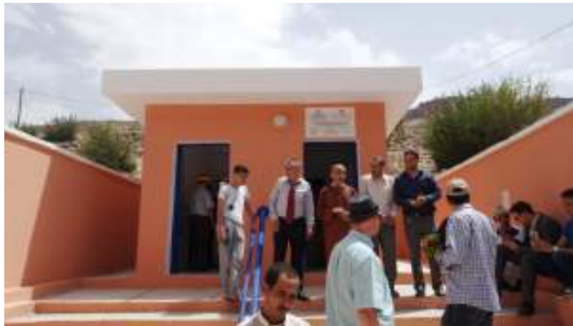
Travaux terminés, ici le local de pompage
