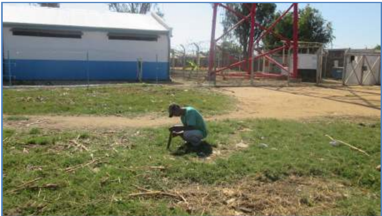
Photo 2 : Matérialisation de piquet en bois du point d'implantation
