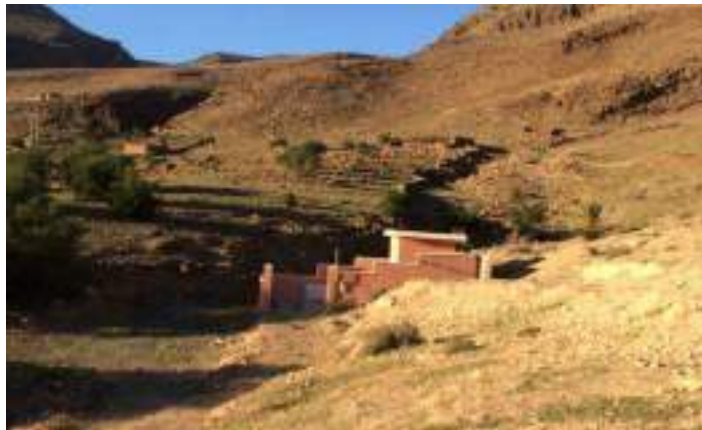
Figure 8 : Forage d'eau potable sur le douar de Maguenoun
