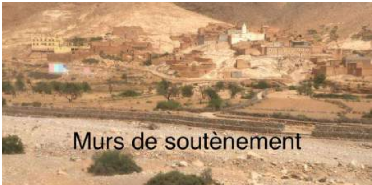
Figure 27: Murs de soutènement dans la commune d'Azaghar N'irs
