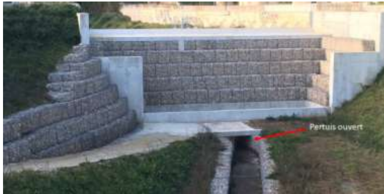
Figure n°16 : Barrage en gabion avec pertuis ouvert
