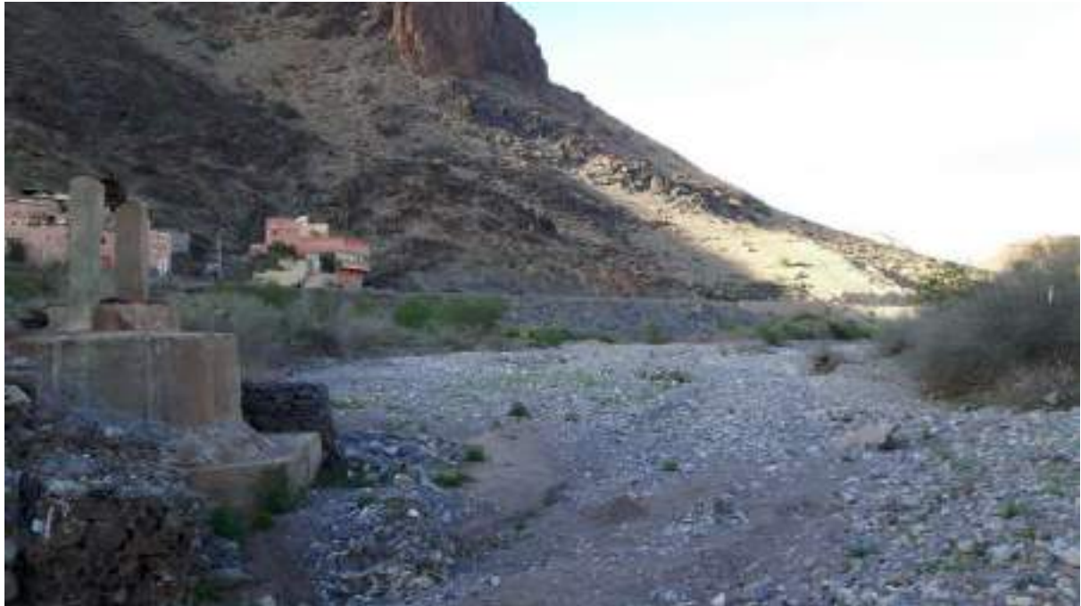
Figure n°10 : Puits de Tiferki entouré d'ouvrages en gabions qui ont été détruits. Le puits est situé dans le lit de l'oued et devrait être protégé par des ouvrages de ralentissement dynamique.
