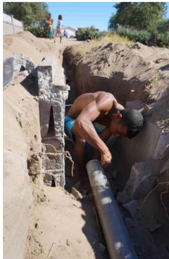
3. Réparation d'une fuite sur la canalisation de Saint Augustin par le technicien plombier de la société d'affermage.
