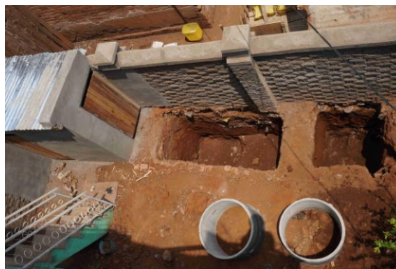
24. Installation de latrines à fosses septiques dans la cour d'une maison à Antsirabe
