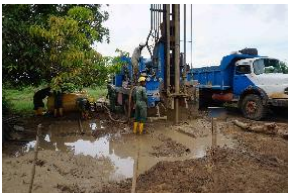
15. Forage à boue, Ambahikily - Entreprise CRS
