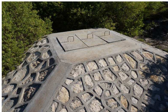
Ouvrage de protection du forage
