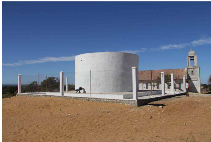
Nouveau réservoir de 115 m 3 non réceptionné
