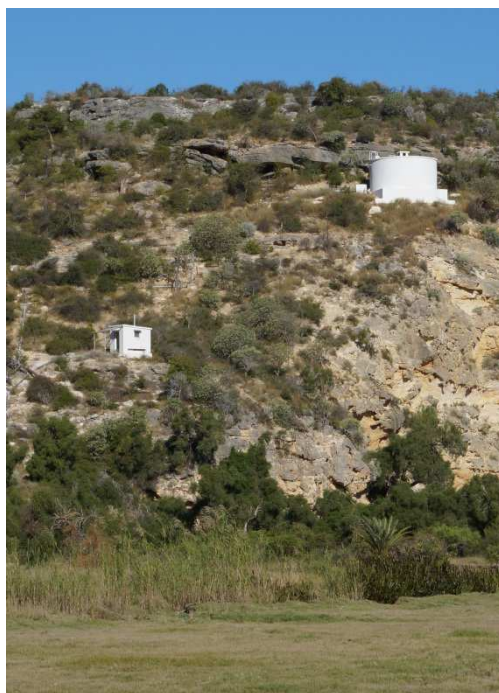
Abri-groupe et réservoir
