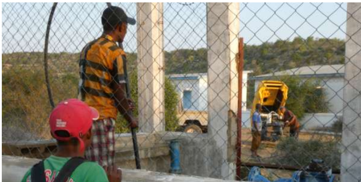
Figure 5 - Soufflage du forage d'Anakao, Août 2018
