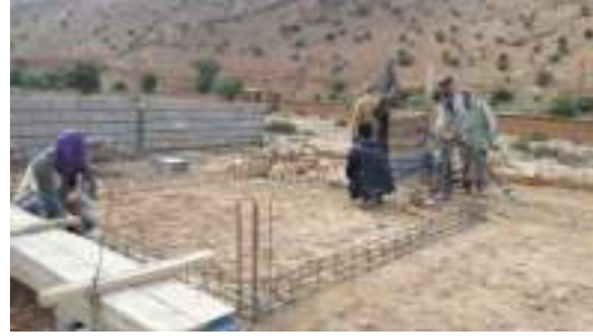
Local de pompage
