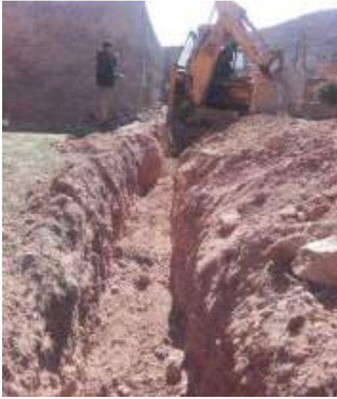
Tranché de conduites 0.8x0.6m
