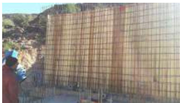
Coffrage des voiles du réservoir
