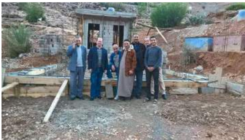
Visite du chantier de Tidriouine par le maire de Marseillan
