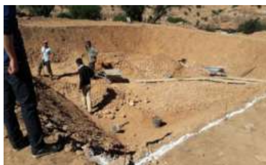
Préparation des bassins de la STEP
