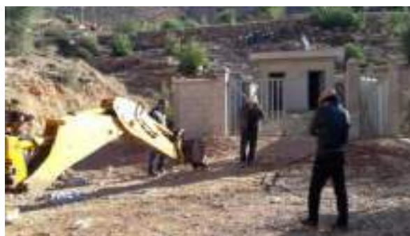
Local du pompage
