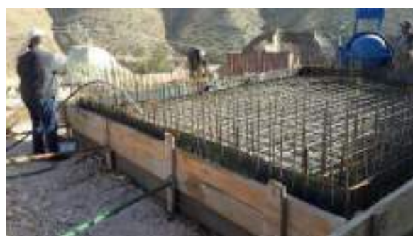
Préparation du radier du réservoir
