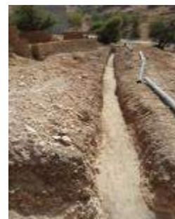
Figure 12 Tranchée avant pose de conduite
