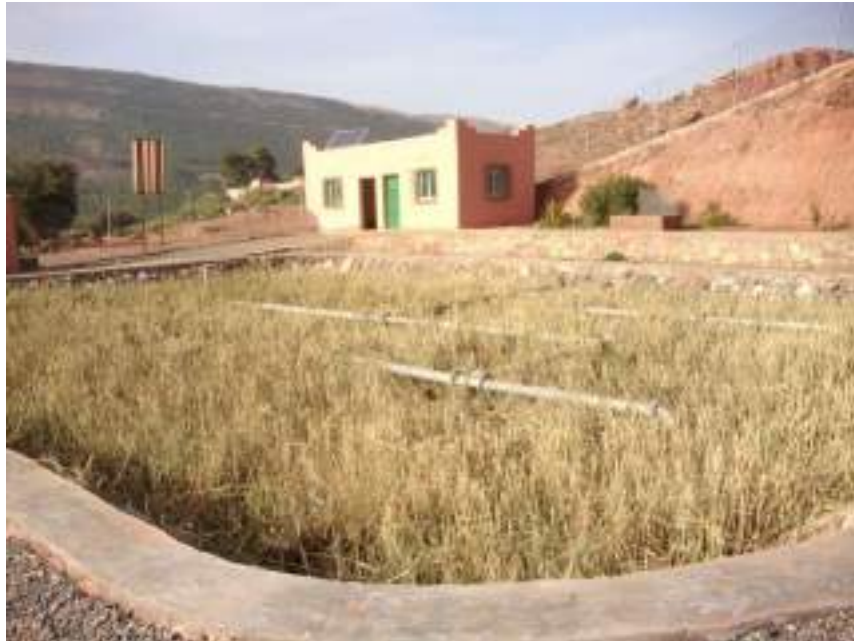
Filtre planté de roseaux d'Asselda
