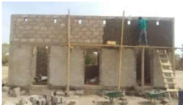
Réalisation du local technique
