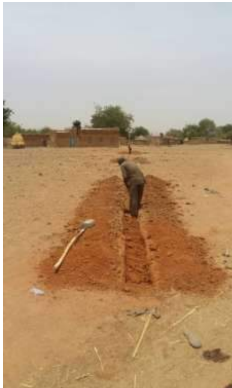
Creusement des tranchées
