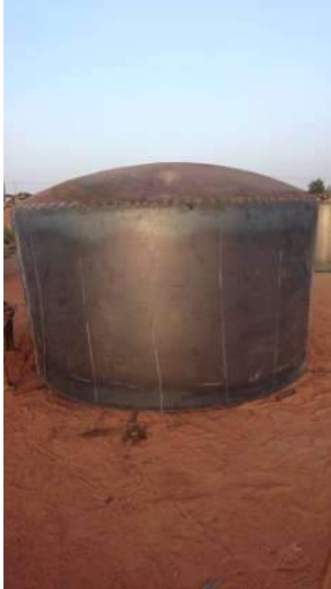
Construction de la cuve du château d'eau
