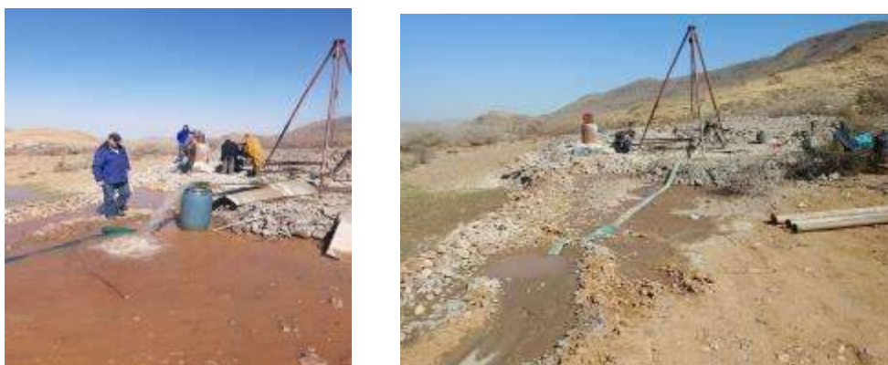
Figure 4 Travaux d'alésage du puits
