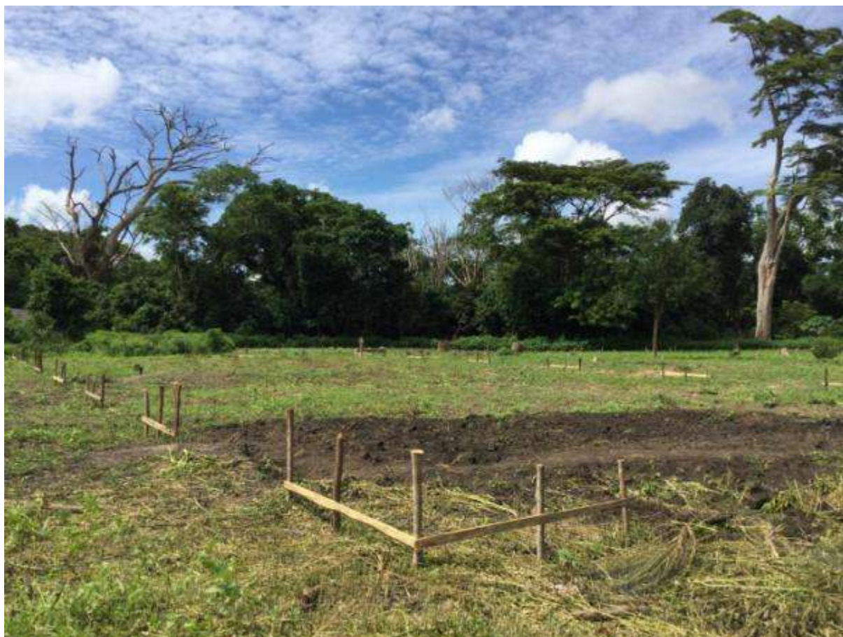
Figure 6 : Implantation de la centrale - 08.01.2019
