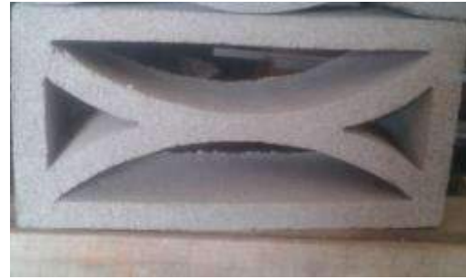
Figure 25 : Ventilation basse (VB)
