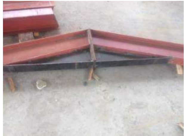
Figure 3: raccordement des traverses au niveau de la faitière
