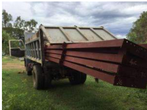
Figure 15 : chargement de la charpente - 14.01.2019
