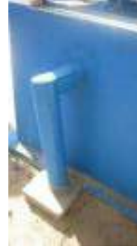
Figure 42 : Conduite de refoulement protégée
