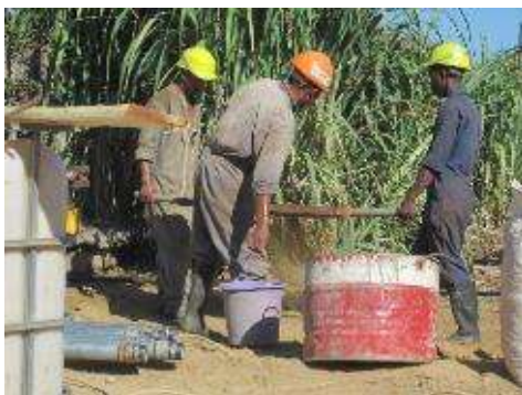
Figure 13 : Tamisage du sable pour la margelle en béton
