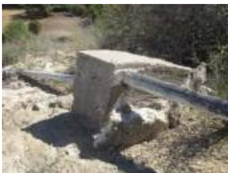
Figure 86 : Plot pour protéger une conduite hors sol
