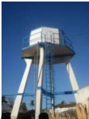
Figure 69 : Réservoir en béton armé
