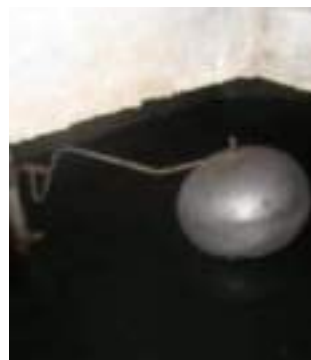
Figure 76 : Flotteur mécanique
