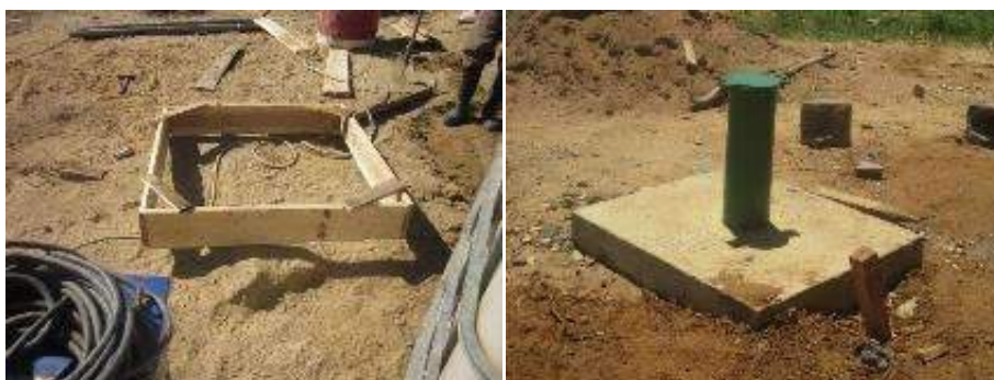
Figure 14 : protection de la tête de forage d'Ankililoaka
