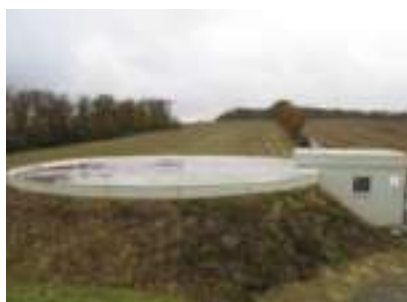
Figure 66 : Réservoir semi-enterré
