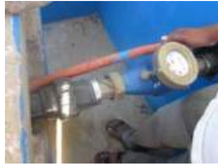
Figure 44 : Compteur de production
