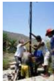
Figure 62 : Installation de la pompe à Saint Augustin
