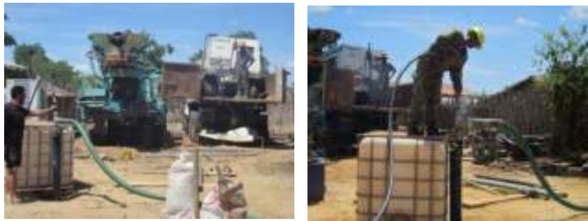
Figure 26 : Déclenchement du tuyau PEHD de la colonne
