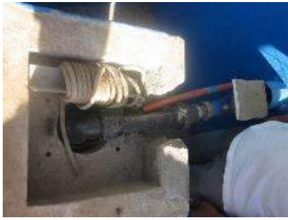
Figure 41 : Coude et début conduite de refoulement
