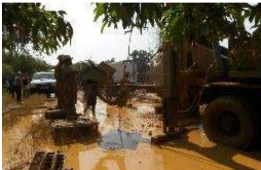
Figure 20 : Inondation suite à un fort débit et coincement des tiges par éboulement
