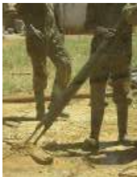
Figure 30 : Nettoyage du fond de forage avant
