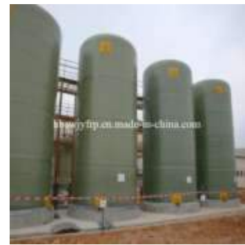
Figure 71 : Réservoir d'eau en fibre de verre
