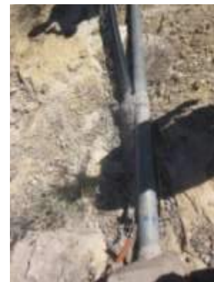
Figure 64 : Protection des câbles électriques
