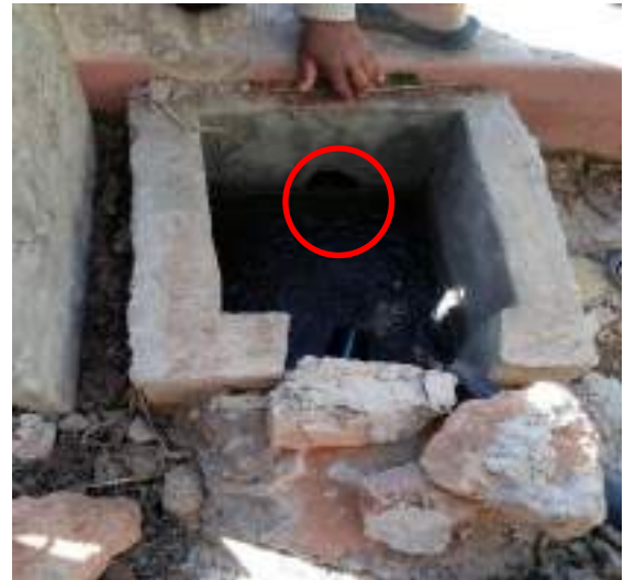
Photo 10 : Entrée de l'eau de source qui mériterait une petite grille au niveau du cercle rouge
