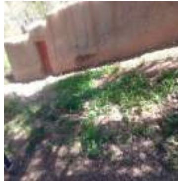
Photo 7 : Tronçon sur lequel la profondeur de la canalisation n'est pas connue
