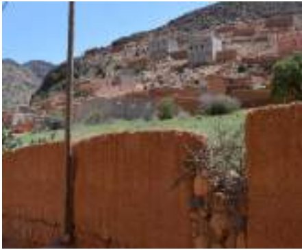
Photo 6 : Maisons en construction qui pourraient avoir des problèmes de pression à cause de leurs altitudes
