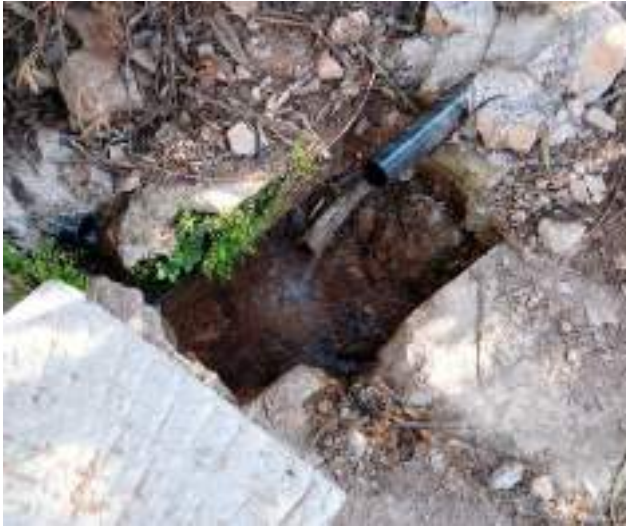
Photo 9 : Captage de la source exposée
