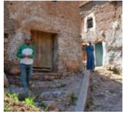
Photo 8 : Canalisation traversant la parcelle du particulier mécontent
