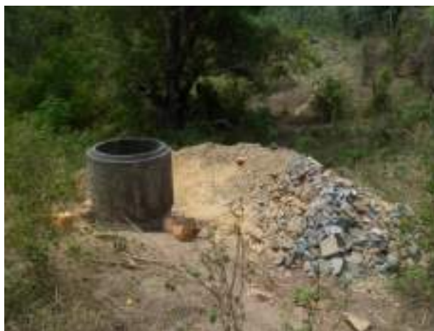
Mise en place de buses
