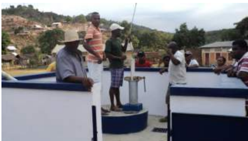
Montage – démontage de la pompe
