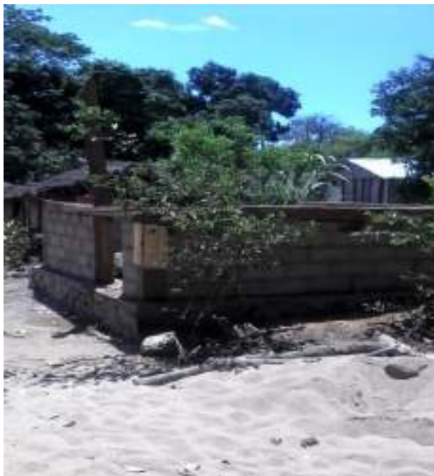
Réalisation des margelles et murs de cloture
