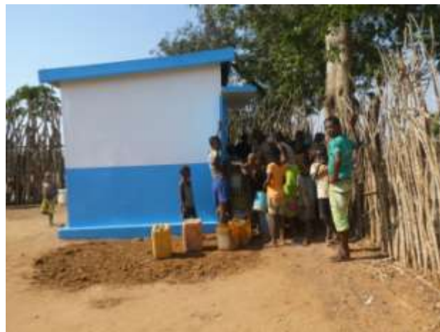
Figure 13 : Kiosque à eau à Ankililoaka
