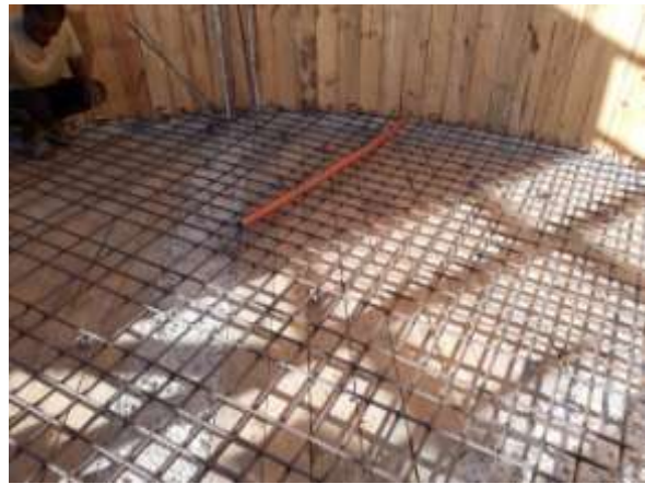
Figure 12 : Mise en œuvre du réservoir
