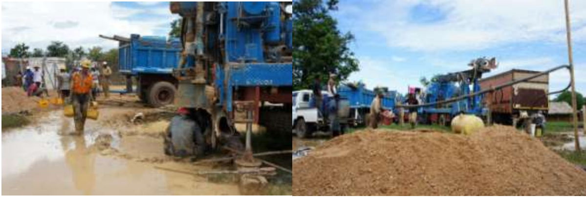
Figure 7 : Pose du massif filtrant et réalisation des essais de pompage
