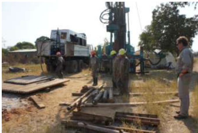
Figure 8 : Supervision du forage par M. Jean Xueref Expert hydrogéologue
