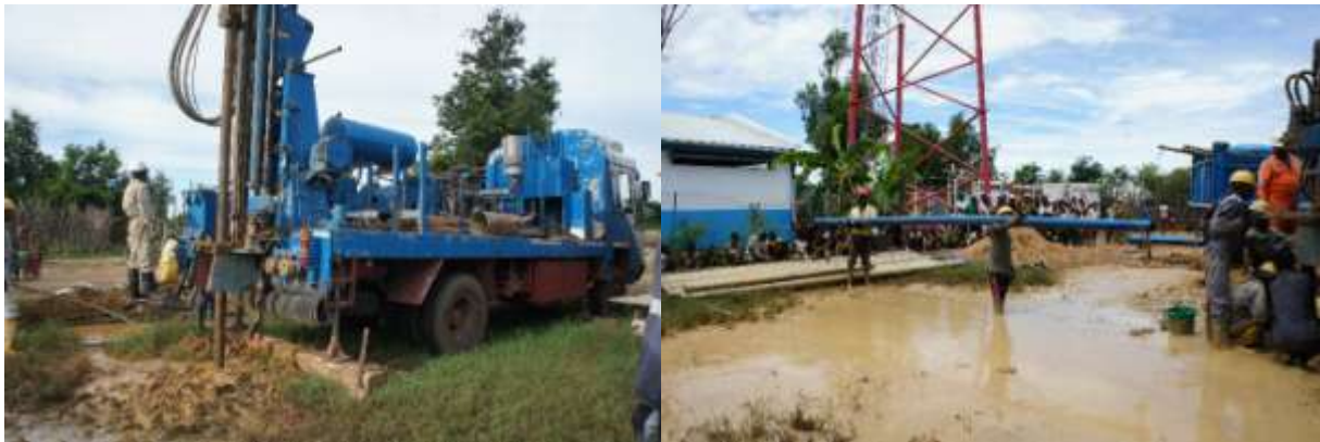
Figure 6 : Réalisation du forage et pose du tubage pour équiper le forage
