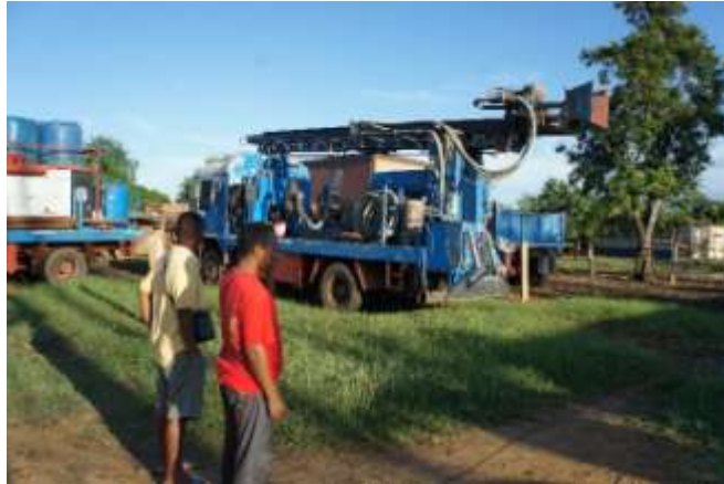
Figure 5 : Vérification des matériels et des matériaux pour la réalisation du forage d'Ankililoaka
