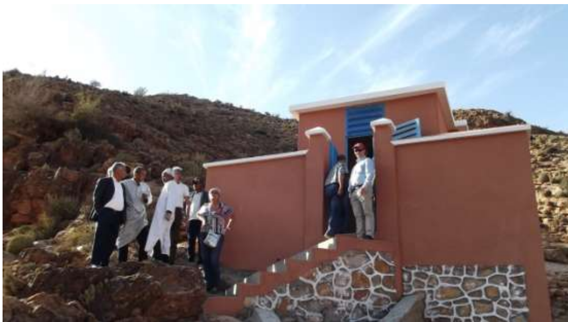
Visite du réservoir d'Idaoulimite
