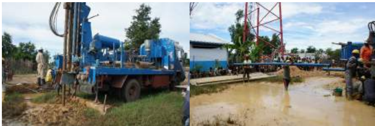
Figure 11 : Réalisation du forage et pose du tubage pour équiper le forage
