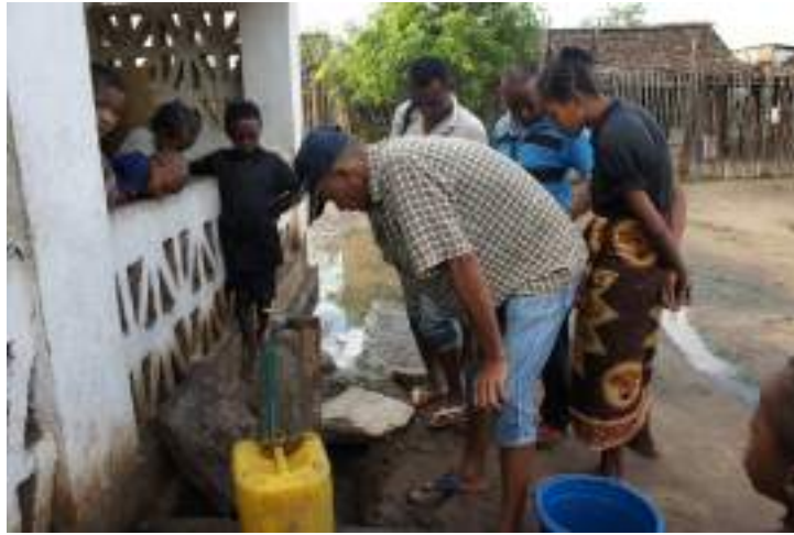
Figure 8 : Vérification d'un branchement privé par la DREAH AA et les gérants du réseau
