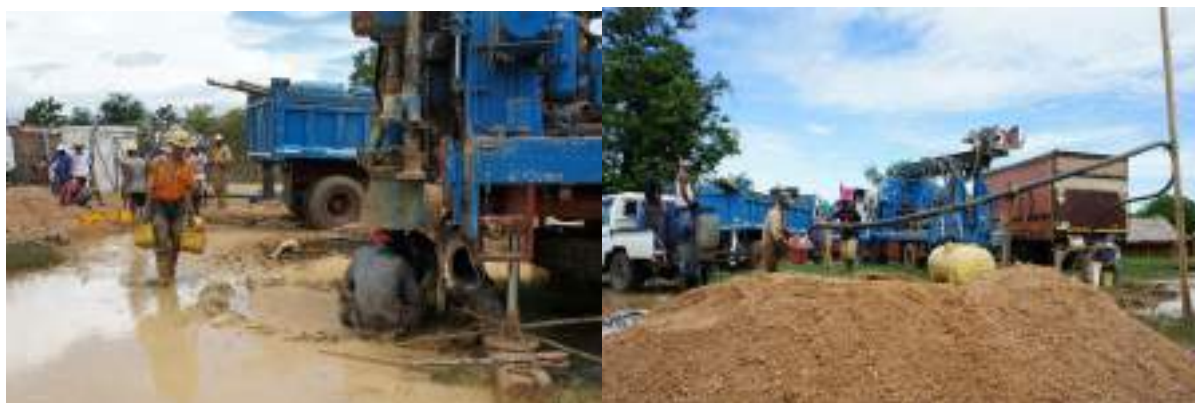
Figure 12 : Pose du massif filtrant et réalisation des essais de pompage
