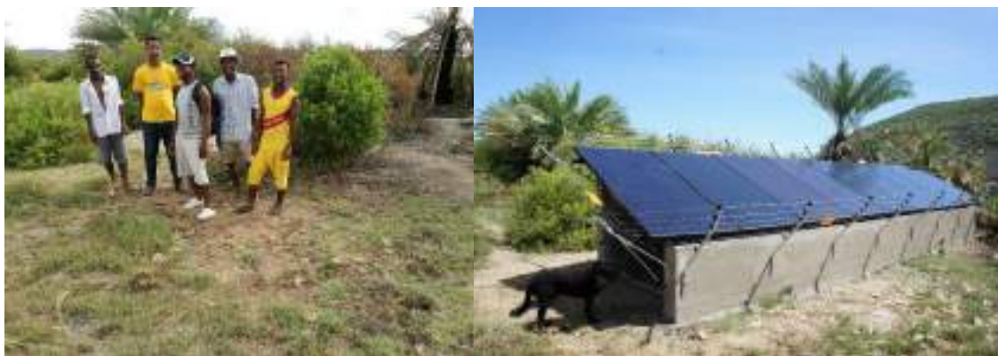
Figure 2 : L'équipe d'installation des panneaux solaires accompagné du délégataire ; Système d'exhaure solaire à Saint Augustin
