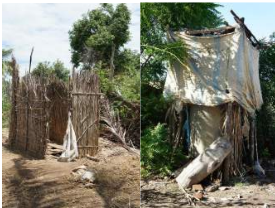
Figure 13 : Latrine en présence à Ambahikily
