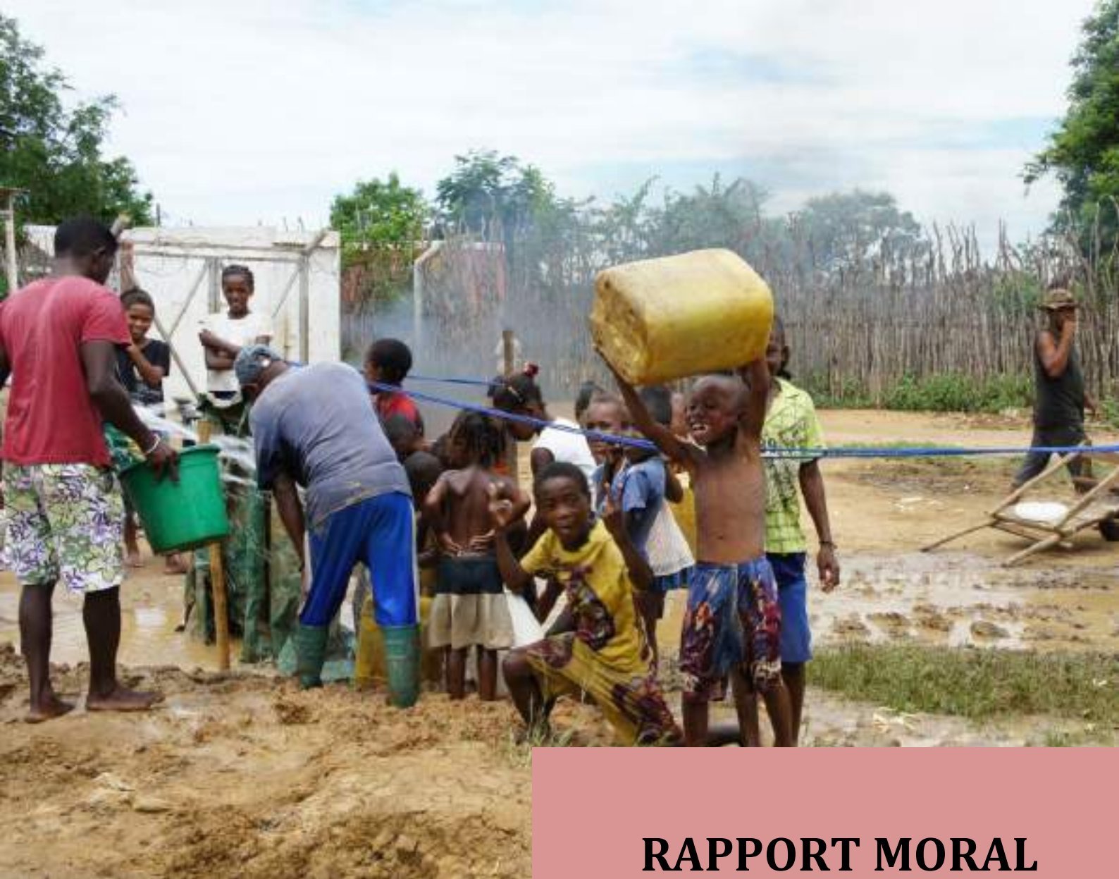
Réalisation du forage d'Ankililoaka, Oct. 2017
