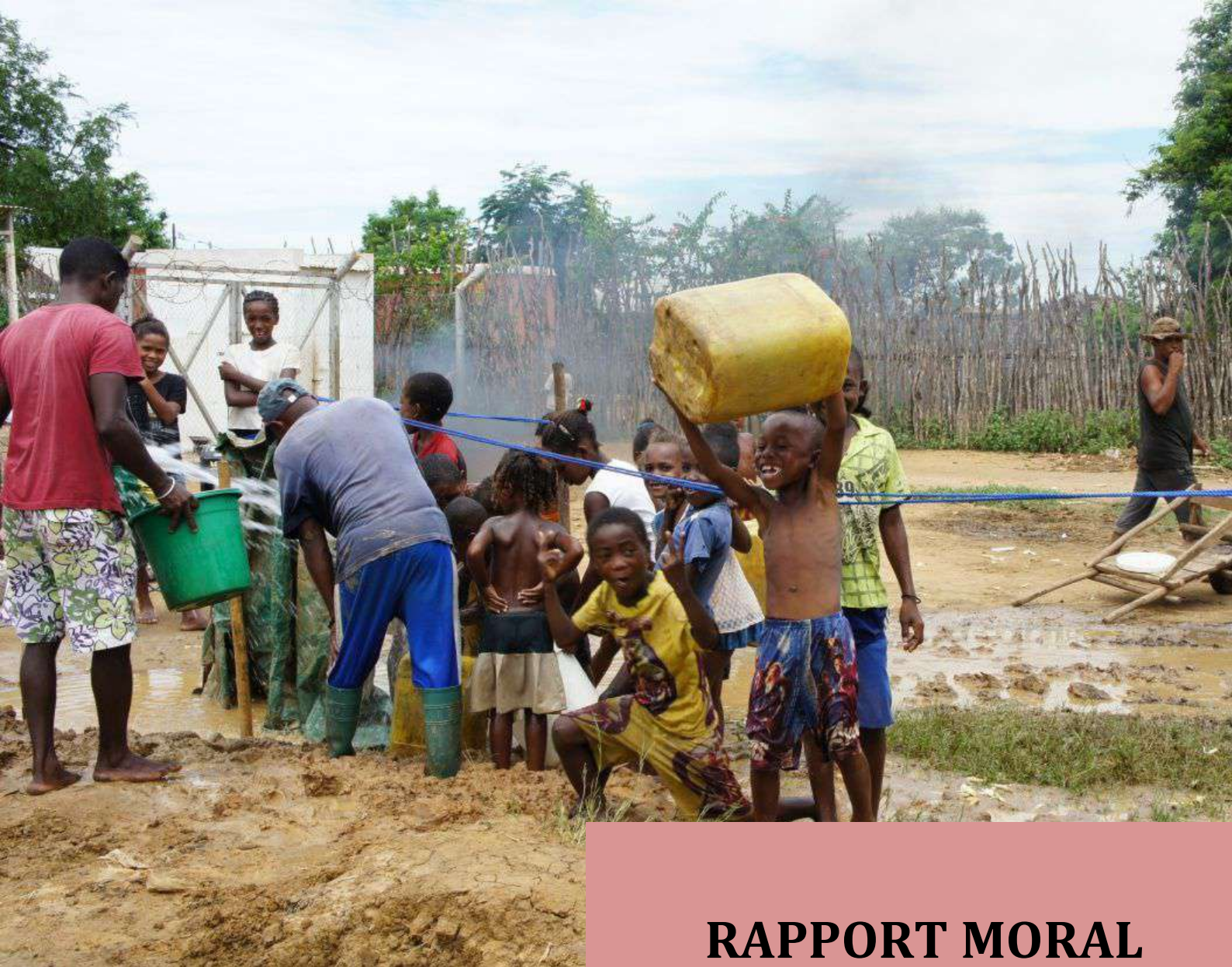
Réalisation du forage d'Ankililoaka, Oct. 2017
