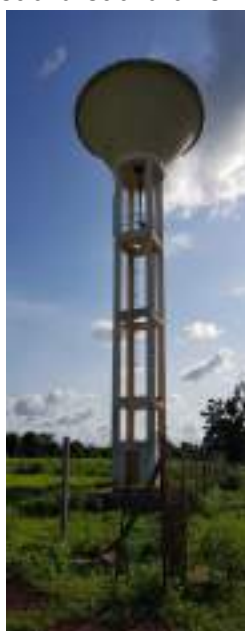
Photographie du château d'eau (et du local technique attenant) de l'AEP de Némataba Centre
