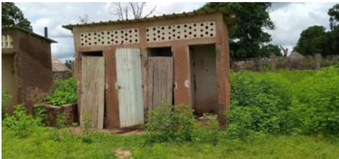
Photographie d'un ancien blocs sanitaire scolaire
