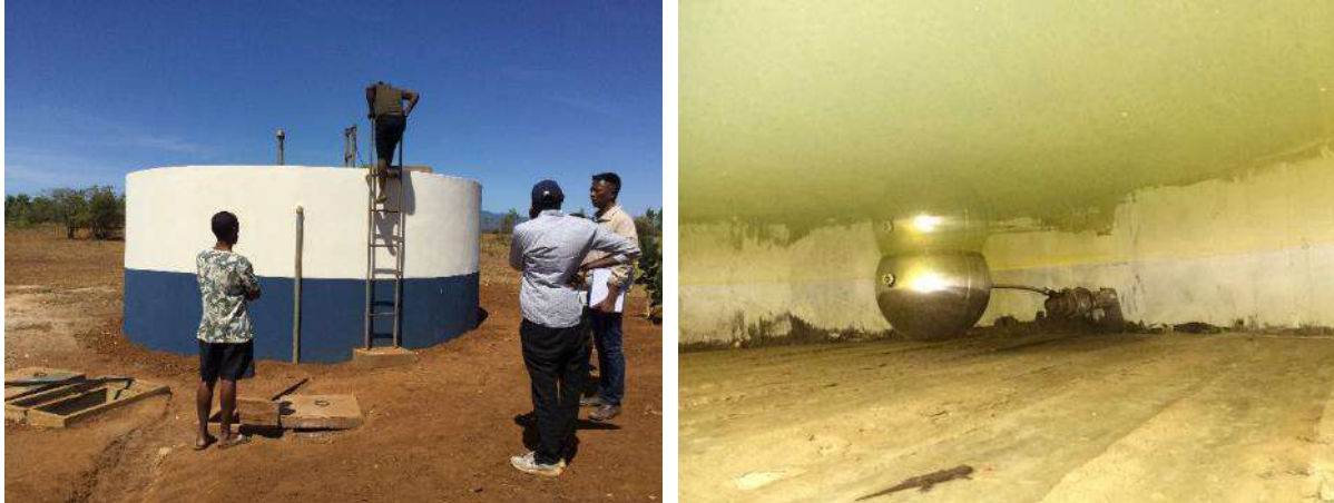
Figure 13 : Réservoir de 50m 3 avec vanne flotteur bloquant l'arrivée d'eau à hauteur maximum / retour au trop plein au niveau de l'unité de filtration
