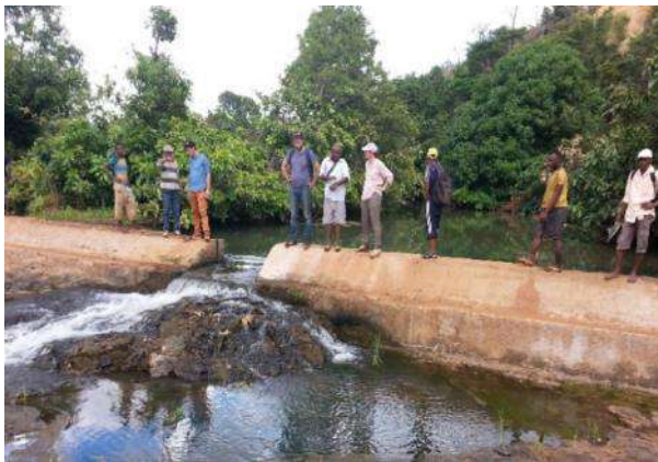
Figure 7 : Barrage avant réhabilitation
