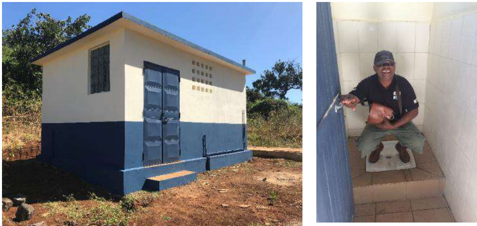
Figure 16 : Bloc sanitaire de l'EPP Ambararatra
