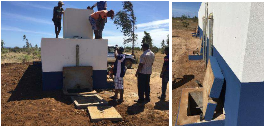
Figure 11 : Unité de filtration
