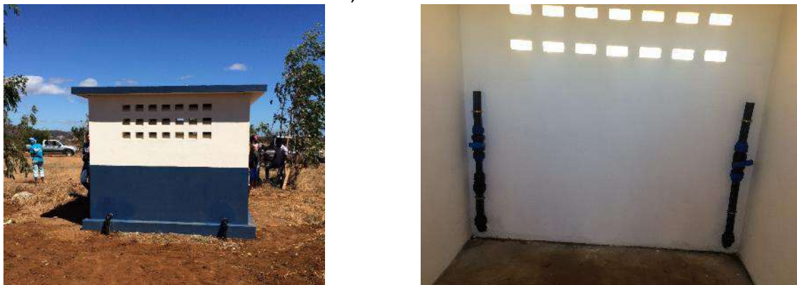
Figure 12 : Local et emplacement réservé pour la pompe doseuse (en cours d'acheminement)
