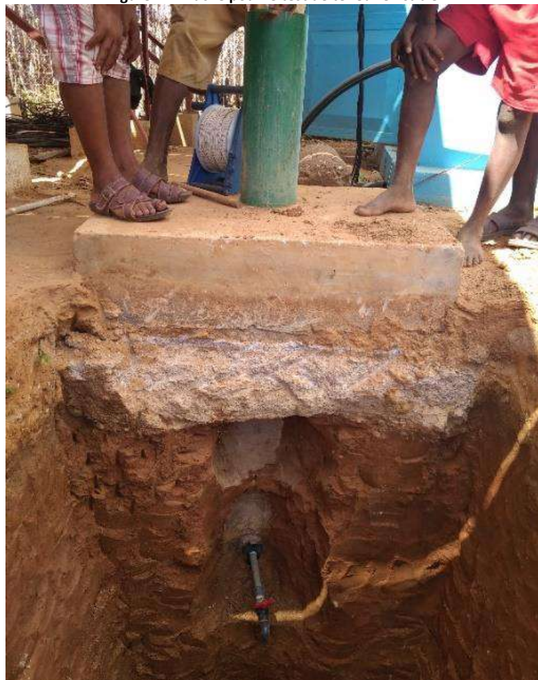
Figure 13 - Fouilles autour du forage pour positionner le premier collier de prise sur le tubage
