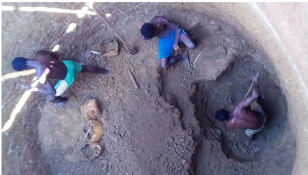
Figure 15 - Avancement des fouilles pour le puits-forages à Ankililoaka
