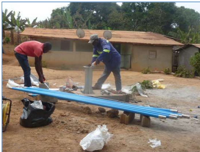
Mini-reportage photos du forage réalisé à OZOM I (Maritime) Foration – Équipement – Nettoyage du forage à l'air-lift – Essais de pompage – Installation de la pompe – Inspection des travaux par la Commune de Lobo © Projet MODEAME-Lobo
