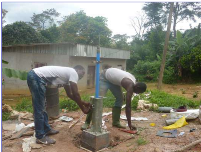
Mini-reportage photos du forage réalisé à EKOUMTIK (entrée Mt Sinai) Foration – Équipement – Installation de la pompe – Inspection des travaux par la Commune de Lobo © Projet MODEAME-Lobo
