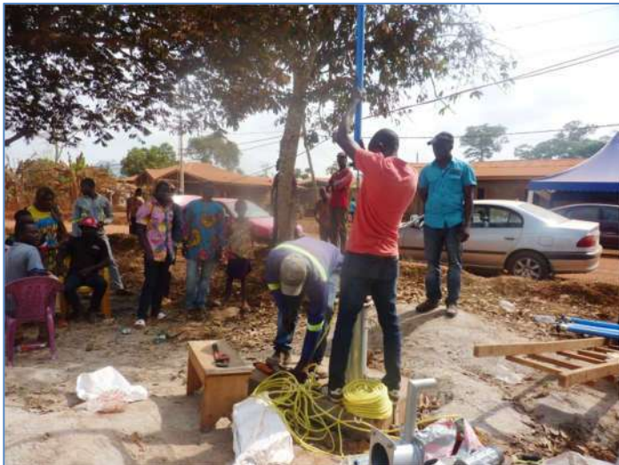
Mini-reportage photos du forage réalisé à OZOM I (Chefferie) Foration – Équipement – Nettoyage du forage à l'air-lift – Installation de la pompe © Projet MODEAME-Lobo
