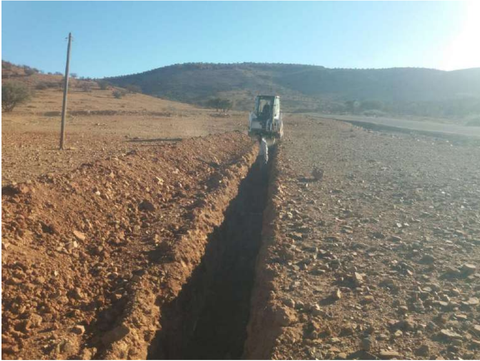
Figure 5 Terrassement des tranchées de la conduite principale
