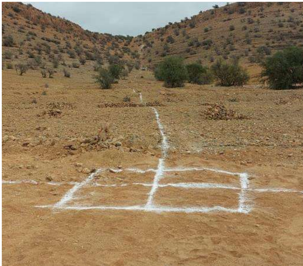
Figure 4 Traçage des tranchées des conduites
