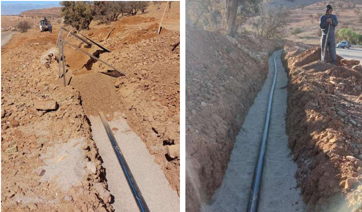
Figure 8 Pose de la conduite et préparation du remblai primaire
