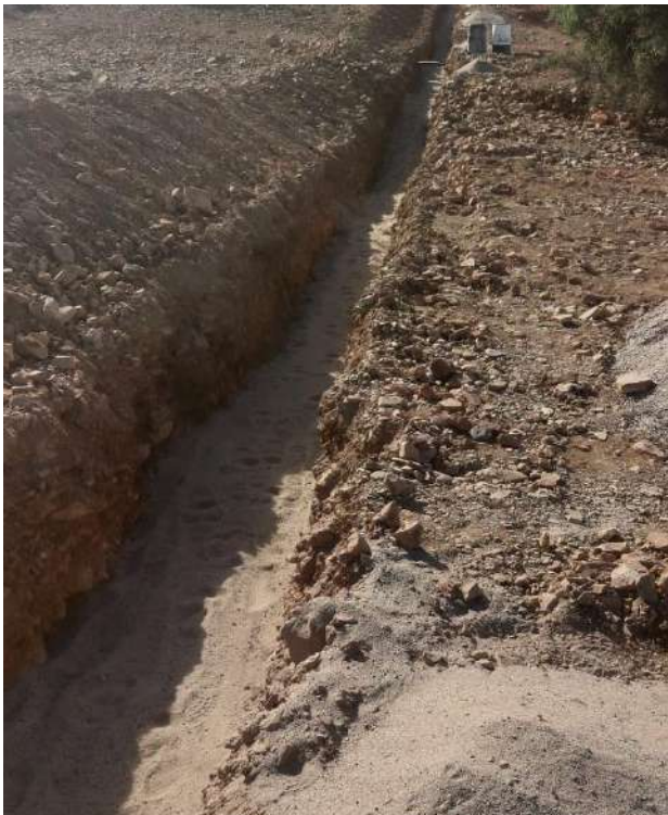
Figure 7 Lit de pose en sable et compactage
