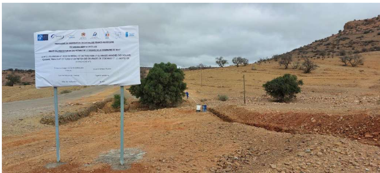
Figure 3 Installation du chantier du deuxième lot de la première tranche
