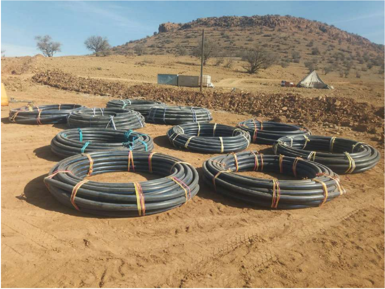
Figure 6 Fourniture de la conduite de PEHD DN90 PN16
