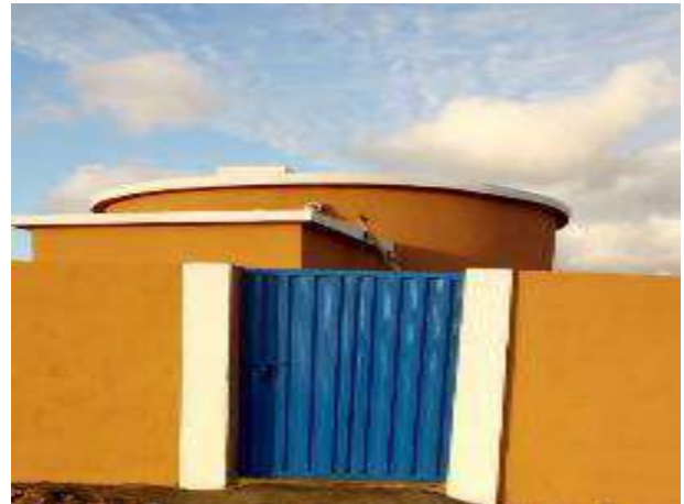
Figure 7: Réservoir semi enterré 100 m 3 d'Ait Ibouk
