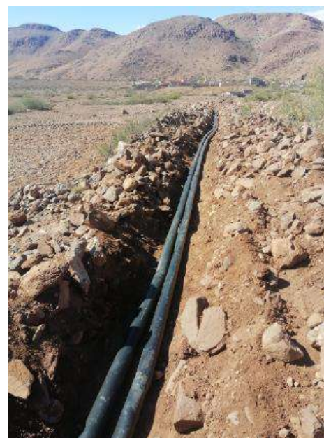
Figure 14 : Conduites entre le réservoir et le local de pompage
