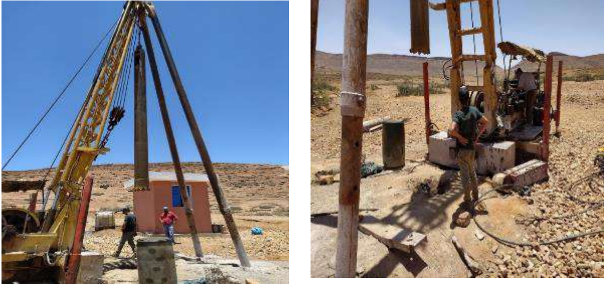
Figure 9: Travaux d'Alésage du forage
