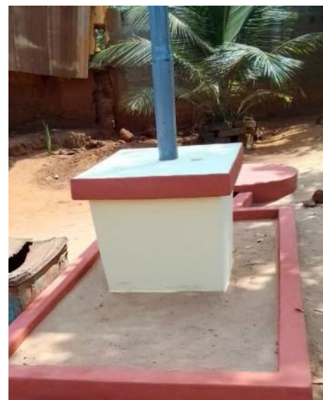
Figure 27 BF réhabilitée à Tokpli
