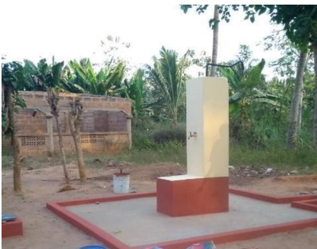
Figure 26 BF construite à Bedjeme
