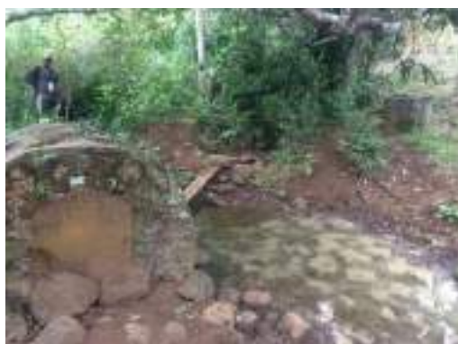
Figure 41 : Réservoir du réseau militaire (en forme de four à pain)
