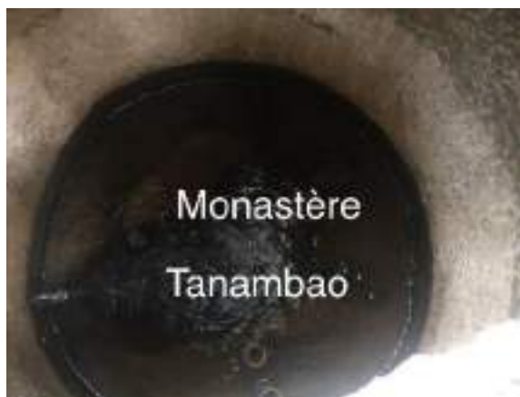
Figure 46 : deux piquages dans ce réservoir un vers le monastère l'autre vers le quartier Tanambao
