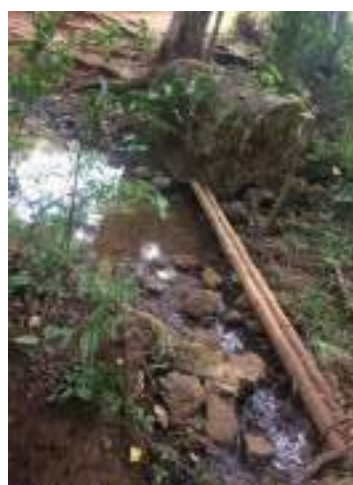
Figure 44 : la conduite d'alimentation réservoir militaire
